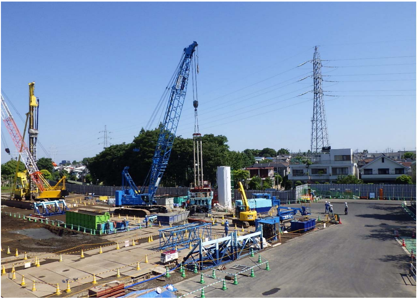
調節池ヤード 北側を望む
