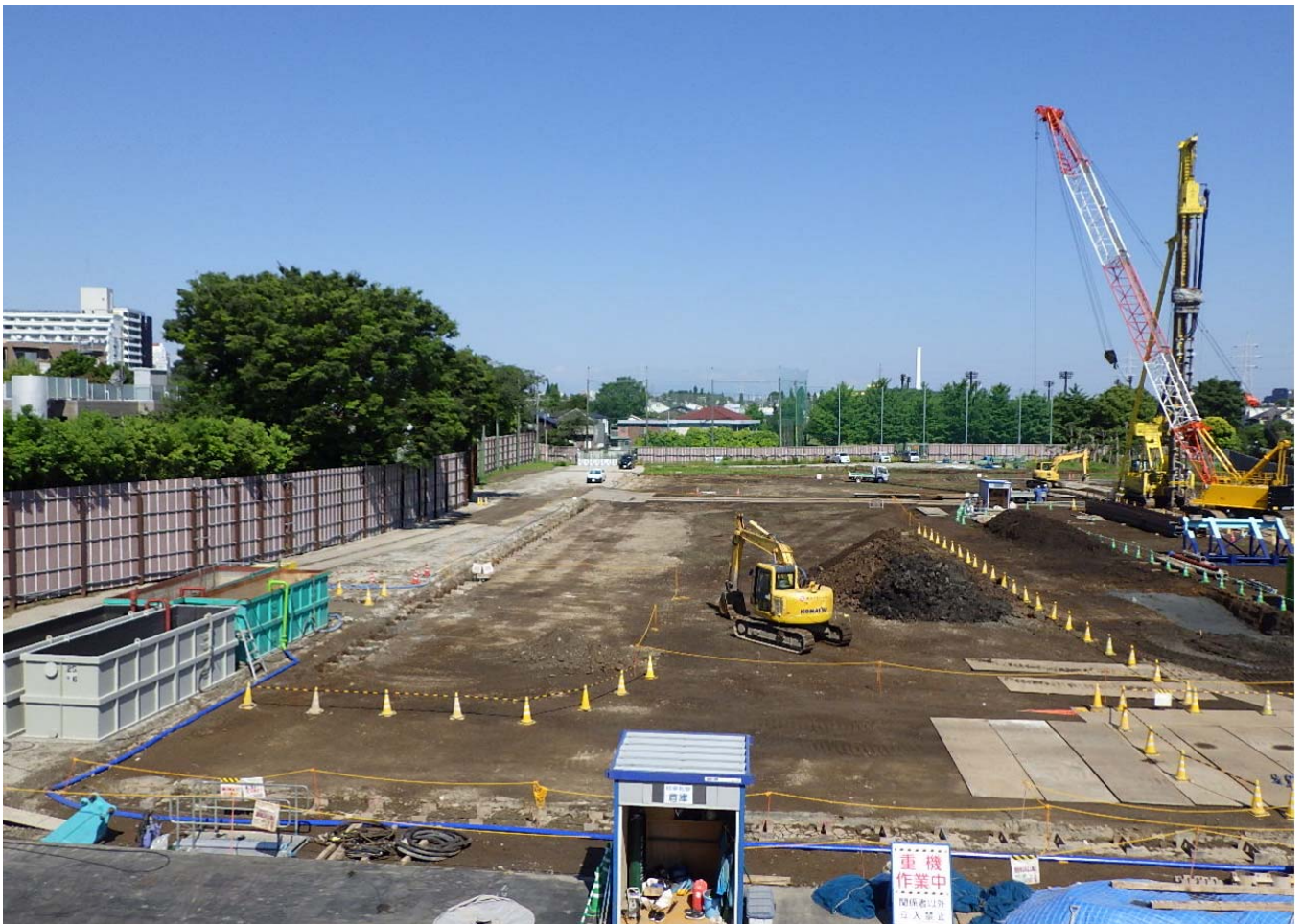
調節池ヤード 南側を望む
