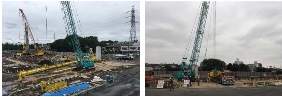
地中連続壁工 2号機 解体搬出状況
