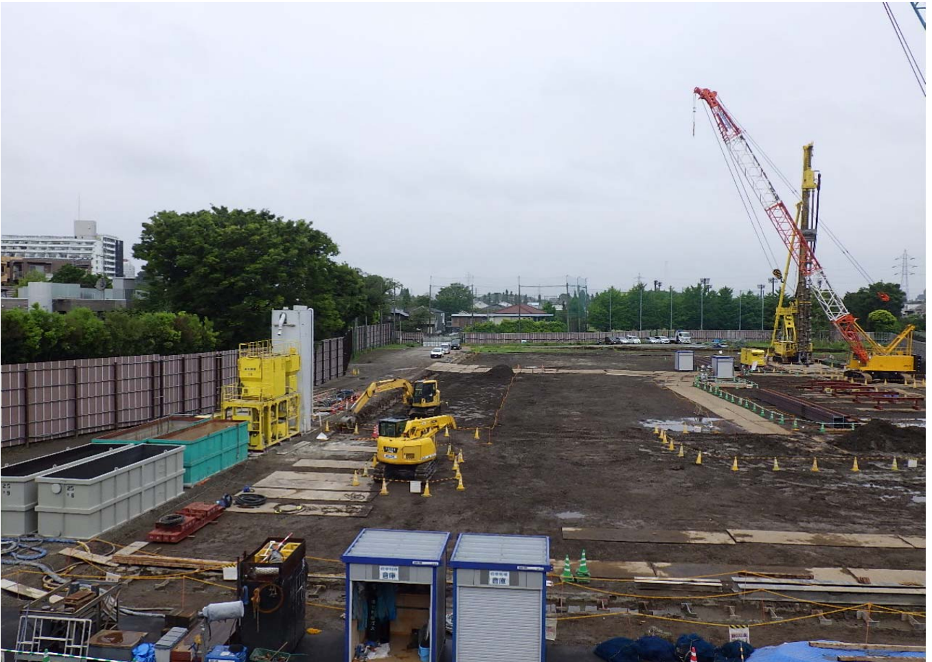
調節池ヤード 南側を望む
