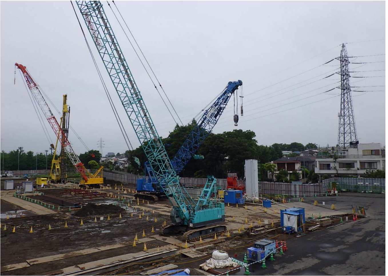
調節池ヤード 北側を望む
