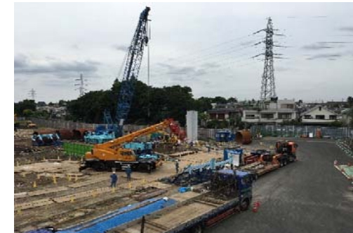
地中連続壁工 2号機 解体搬出状況
