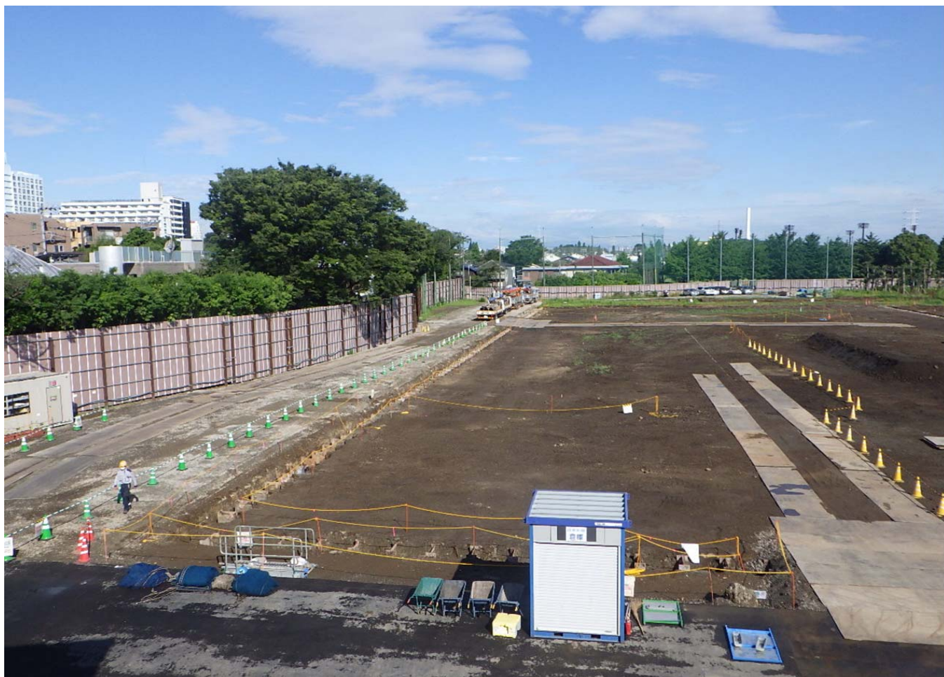
調節池ヤード 南側を望む
