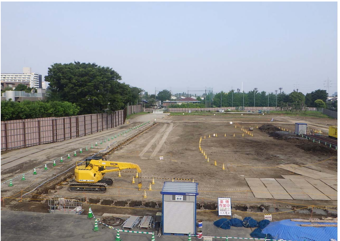
調節池ヤード 南側を望む
