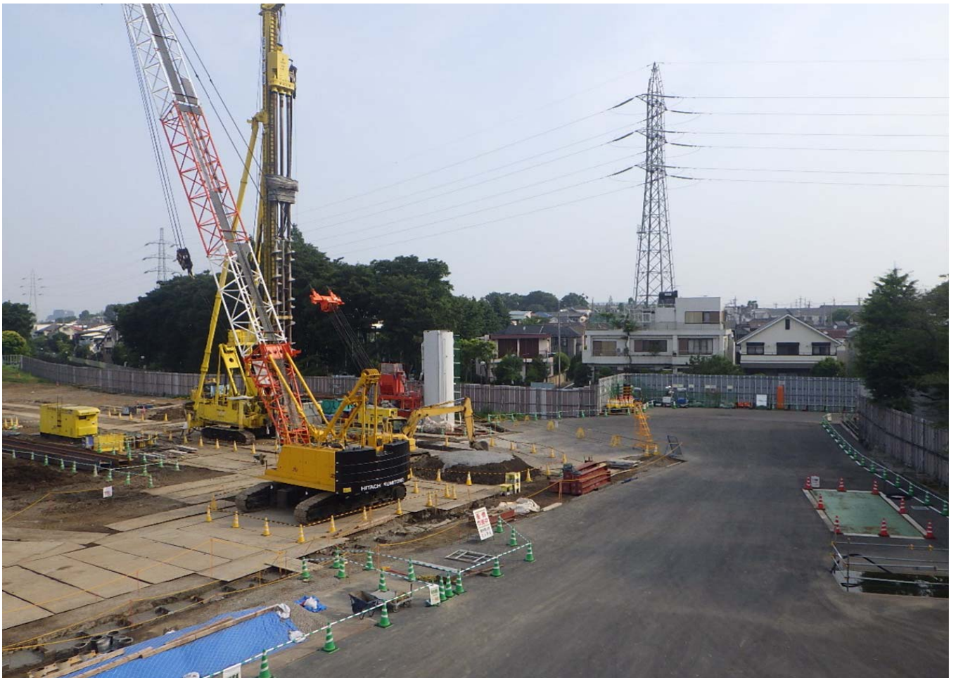
調節池ヤード 北側を望む
