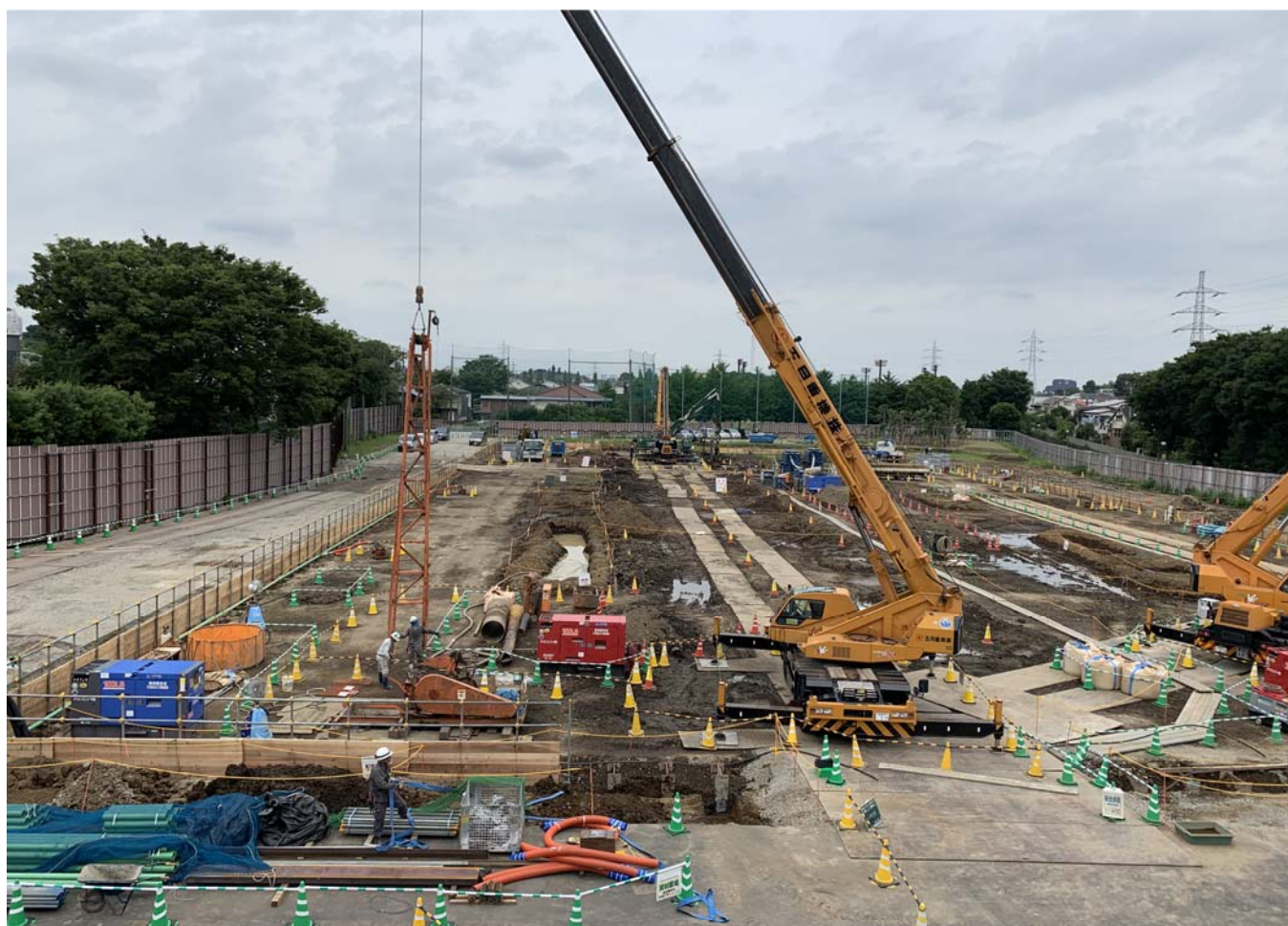
調節池ヤード 南側を望む
