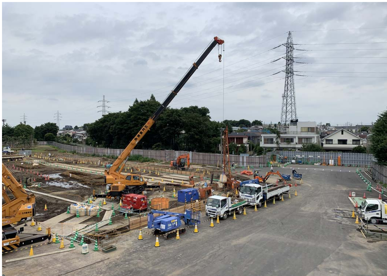
調節池ヤード 北側を望む
