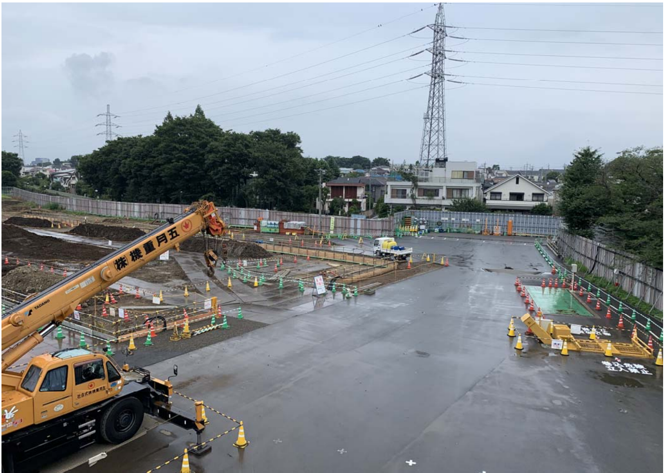
調節池ヤード 北側を望む
