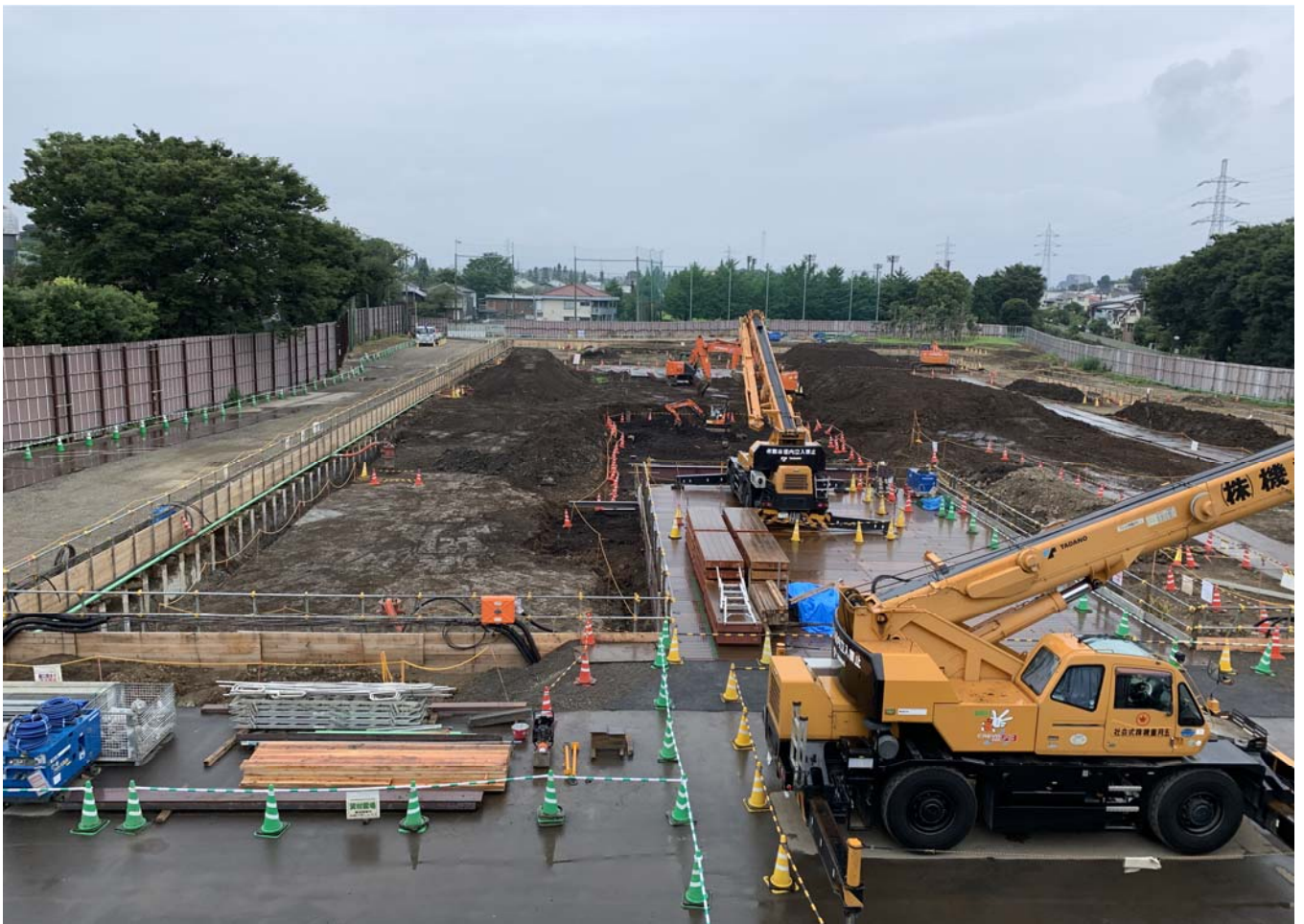
調節池ヤード 南側を望む
