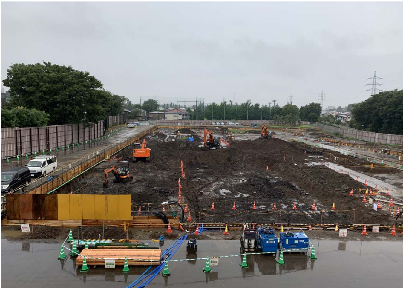
調節池ヤード 南側を望む
