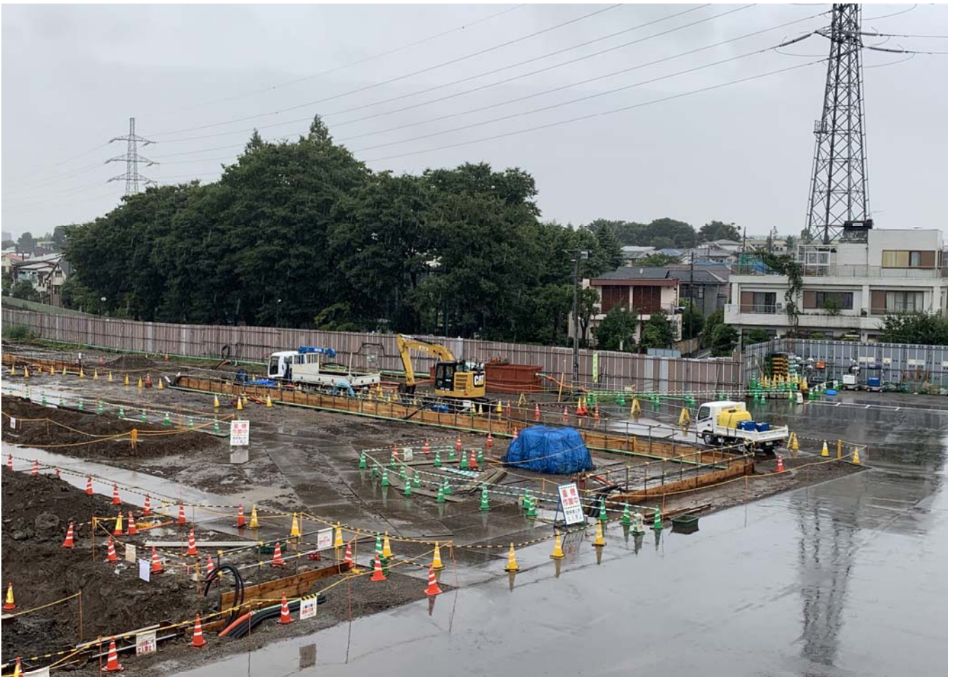
調節池ヤード 北側を望む
