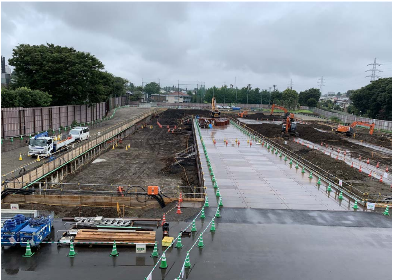
調節池ヤード 南側を望む
