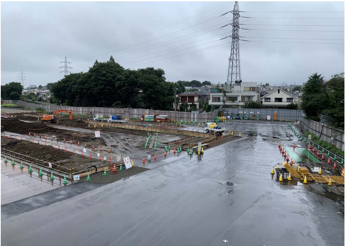
調節池ヤード 北側を望む
