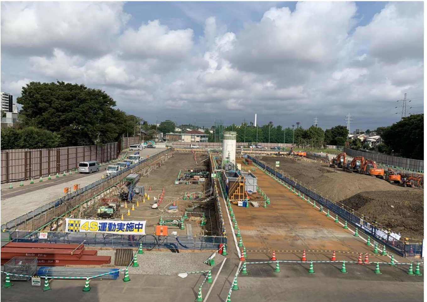
調節池ヤード 南側を望む
