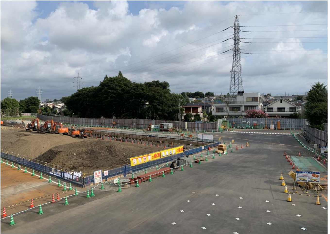
調節池ヤード 北側を望む
