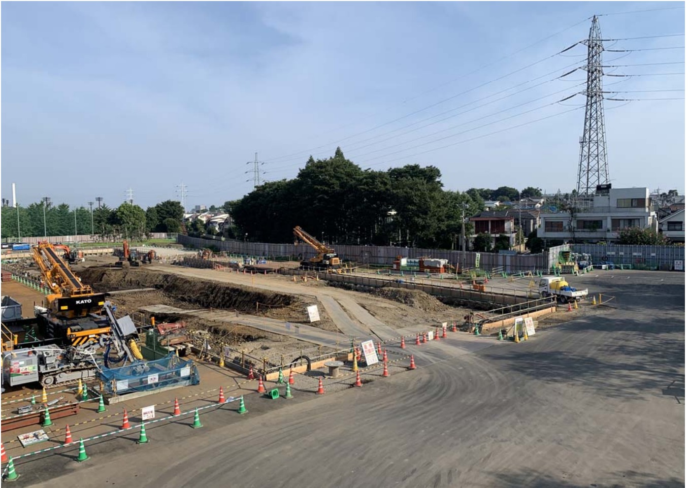
調節池ヤード 北側を望む
