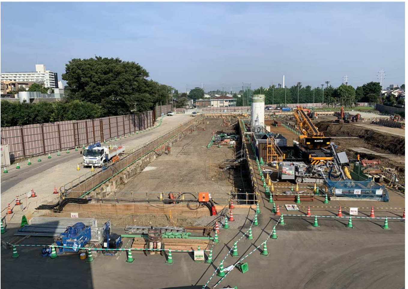
調節池ヤード 南側を望む
