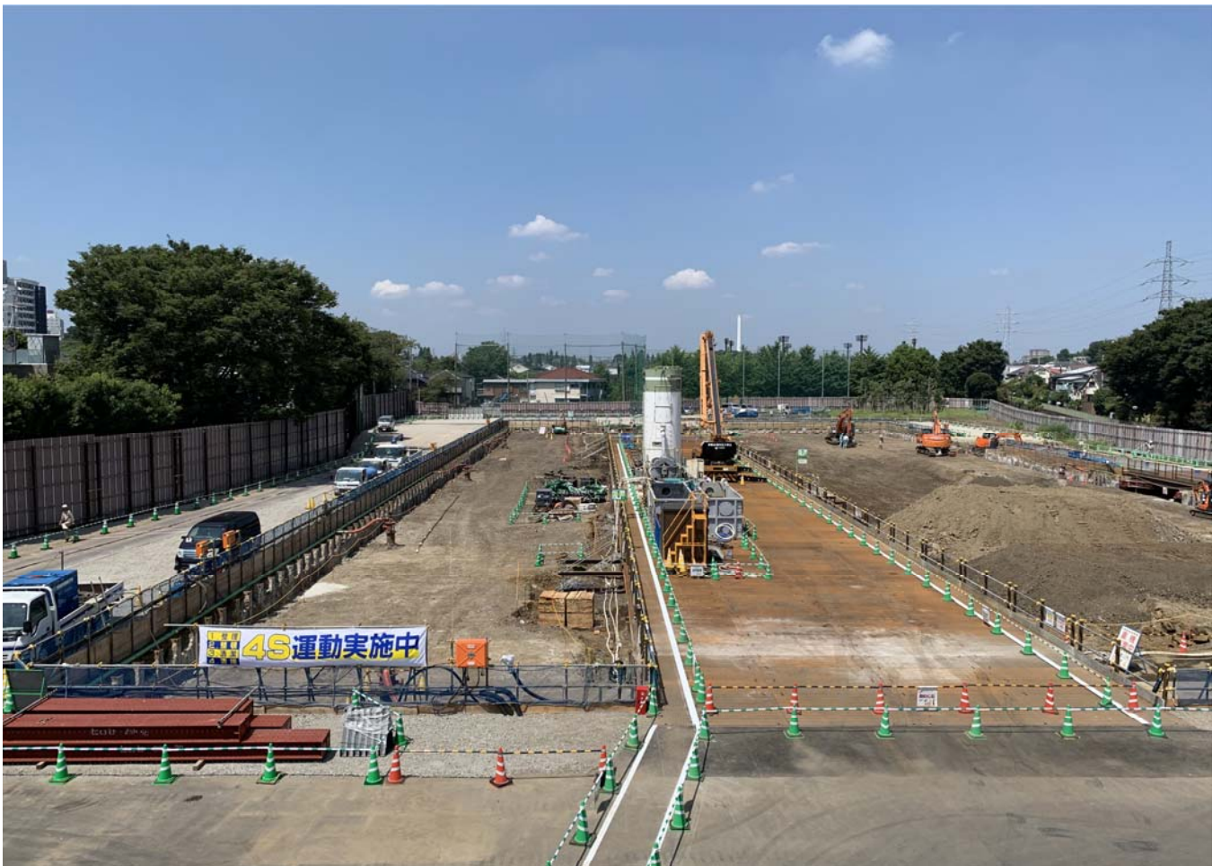
調節池ヤード 南側を望む
