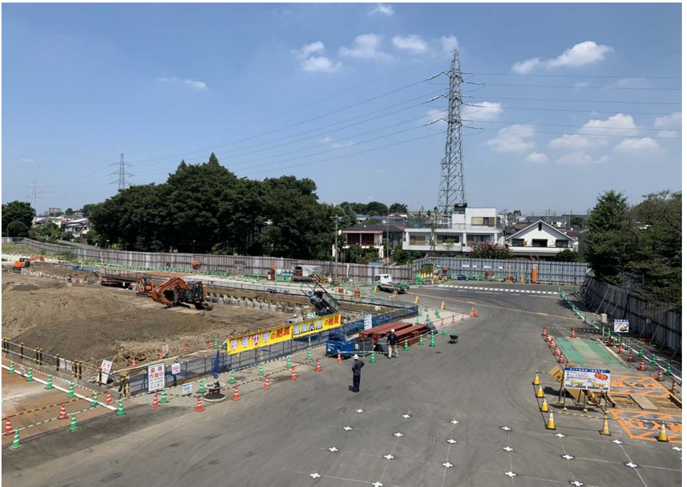
調節池ヤード 北側を望む
