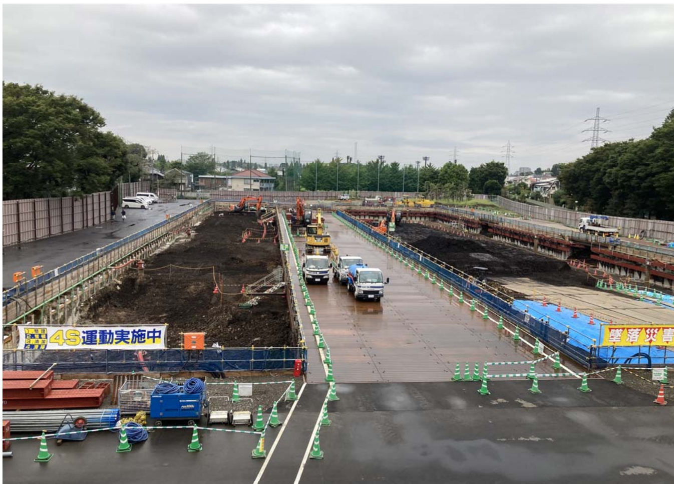
調節池ヤード 南側を望む
