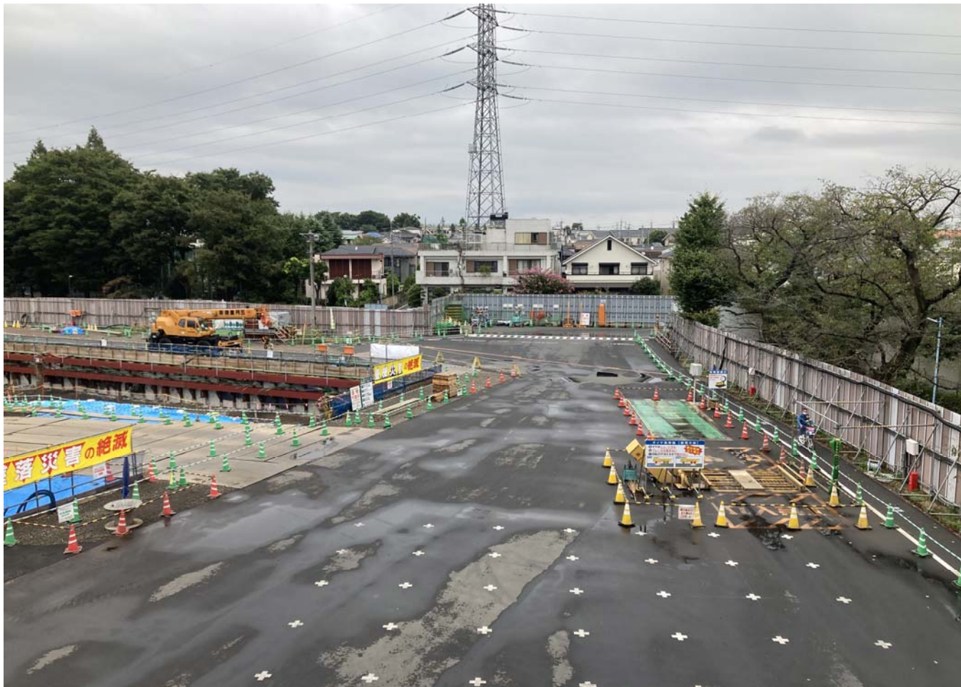
調節池ヤード 北側を望む
