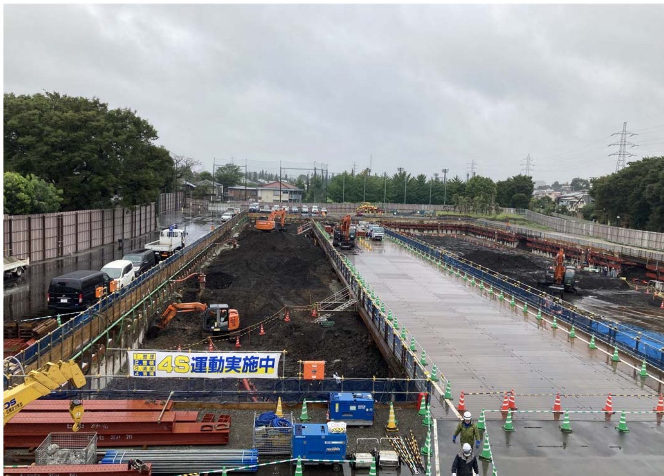
調節池ヤード 南側を望む
