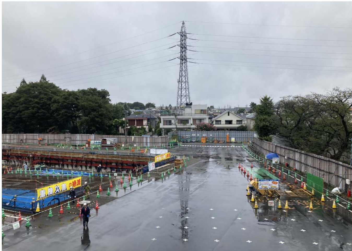
調節池ヤード 北側を望む
