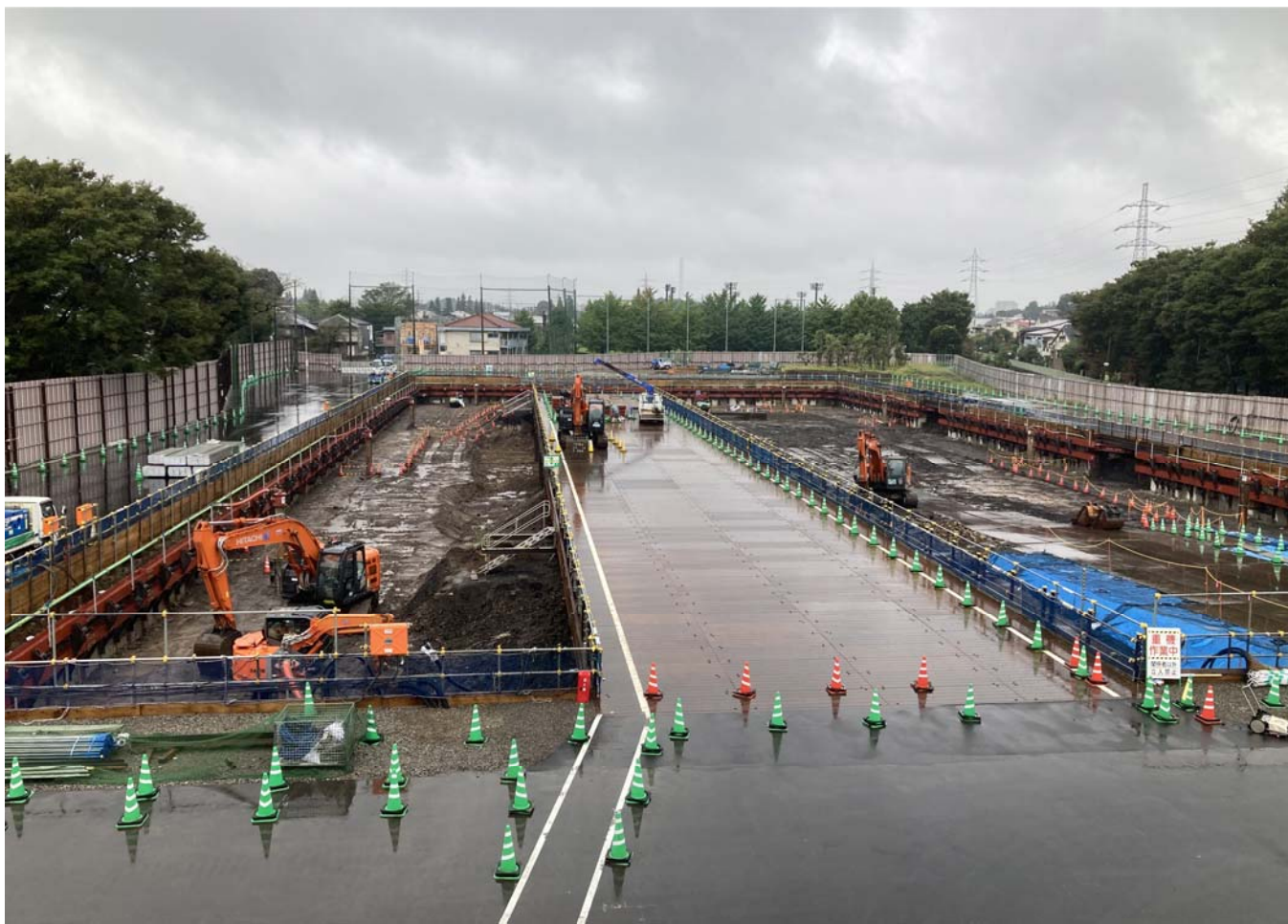
調節池ヤード 南側を望む
