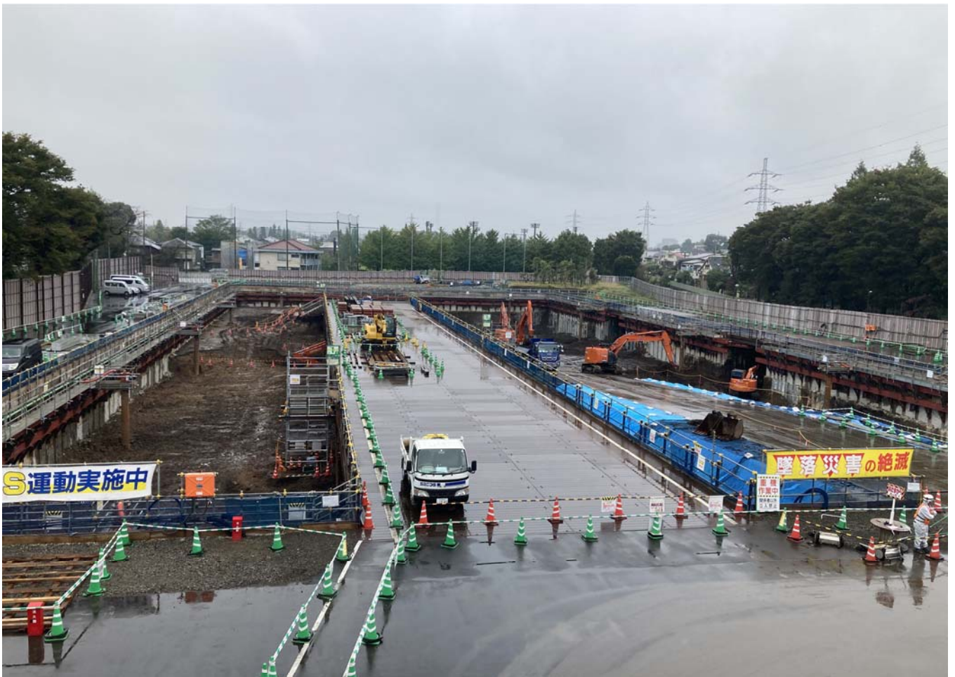
調節池ヤード 南側を望む
