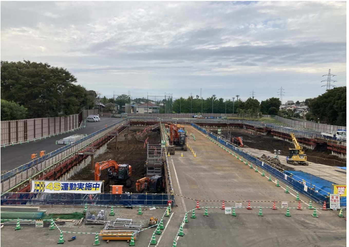
調節池ヤード 南側を望む
