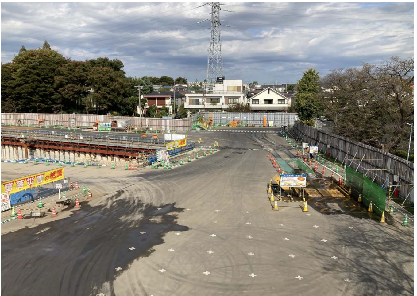
調節池ヤード 北側を望む
