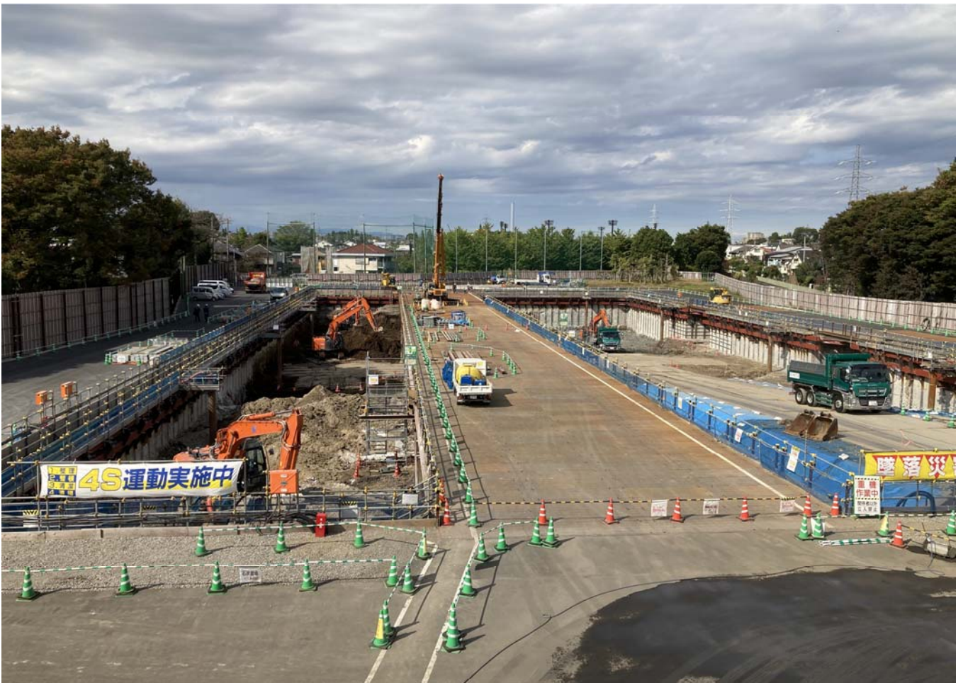
調節池ヤード 南側を望む
