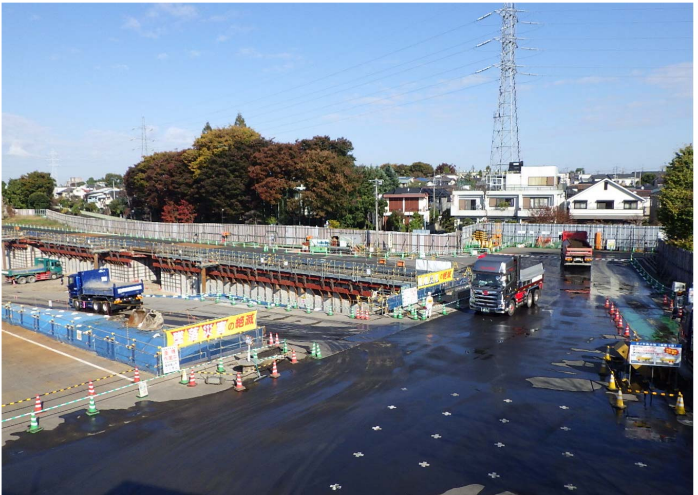
調節池ヤード 北側を望む
