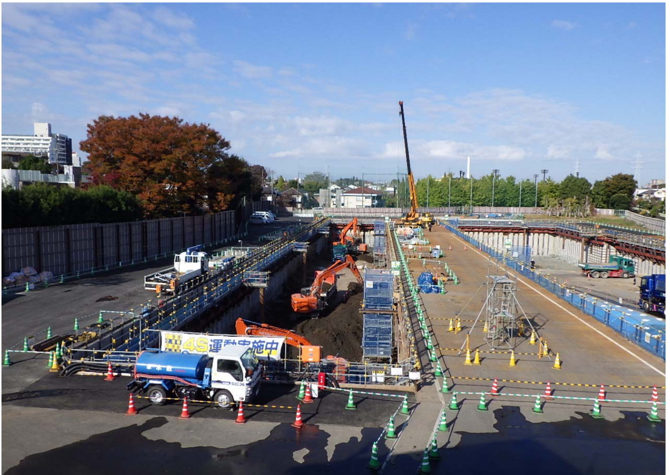
調節池ヤード 南側を望む
