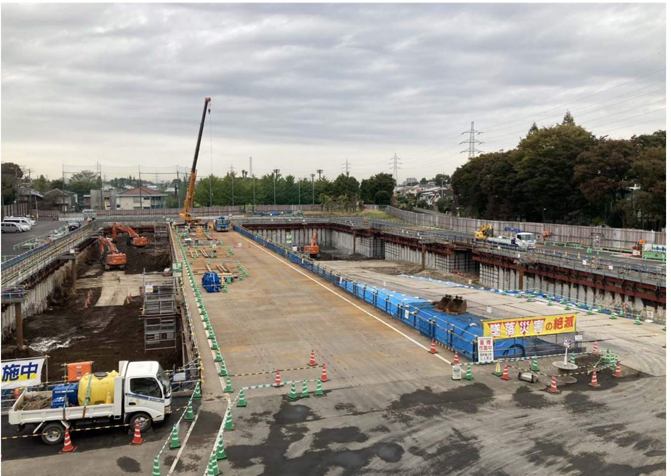
調節池ヤード 南側を望む
