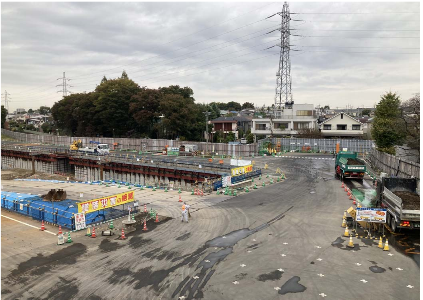
調節池ヤード 北側を望む
