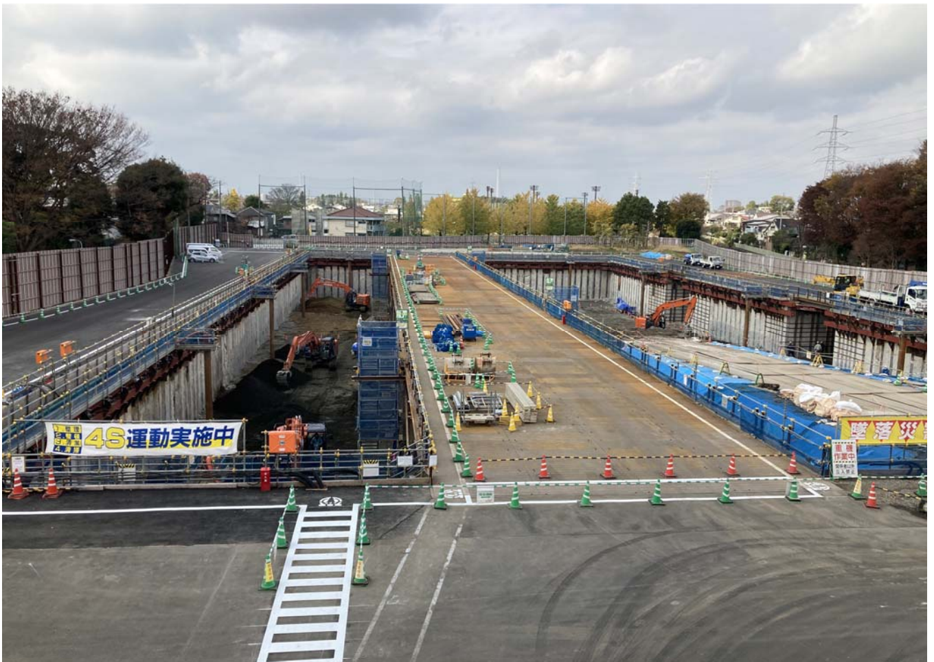
調節池ヤード 南側を望む
