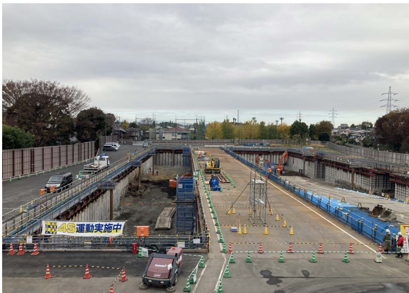
調節池ヤード 南側を望む
