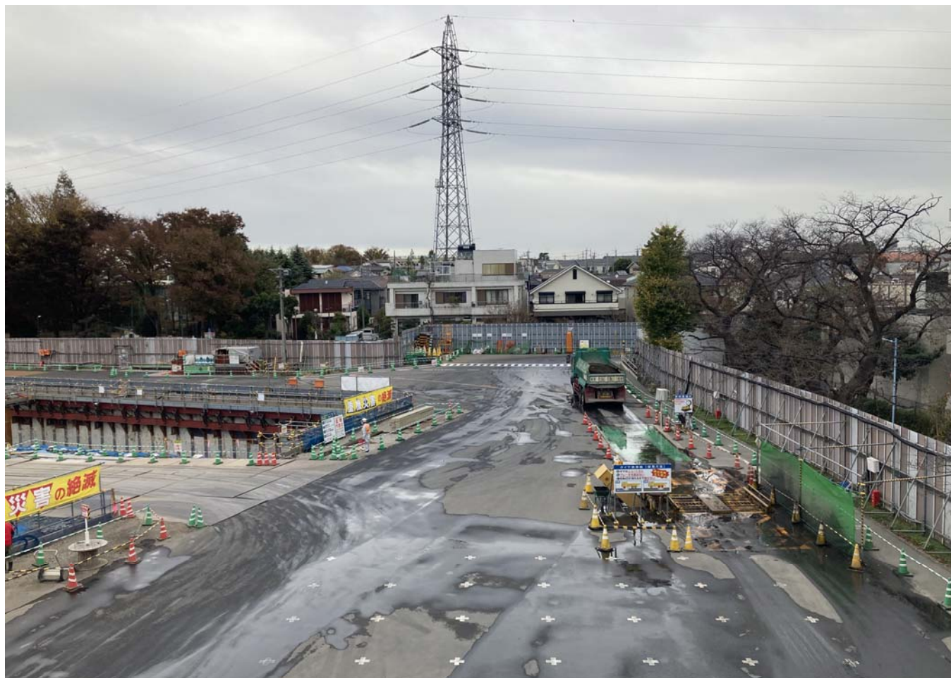
調節池ヤード 北側を望む
