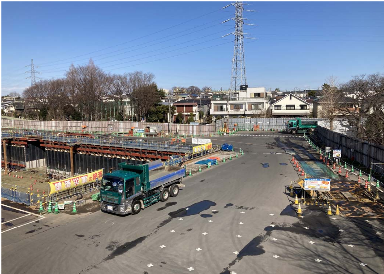
調節池ヤード 北側を望む
