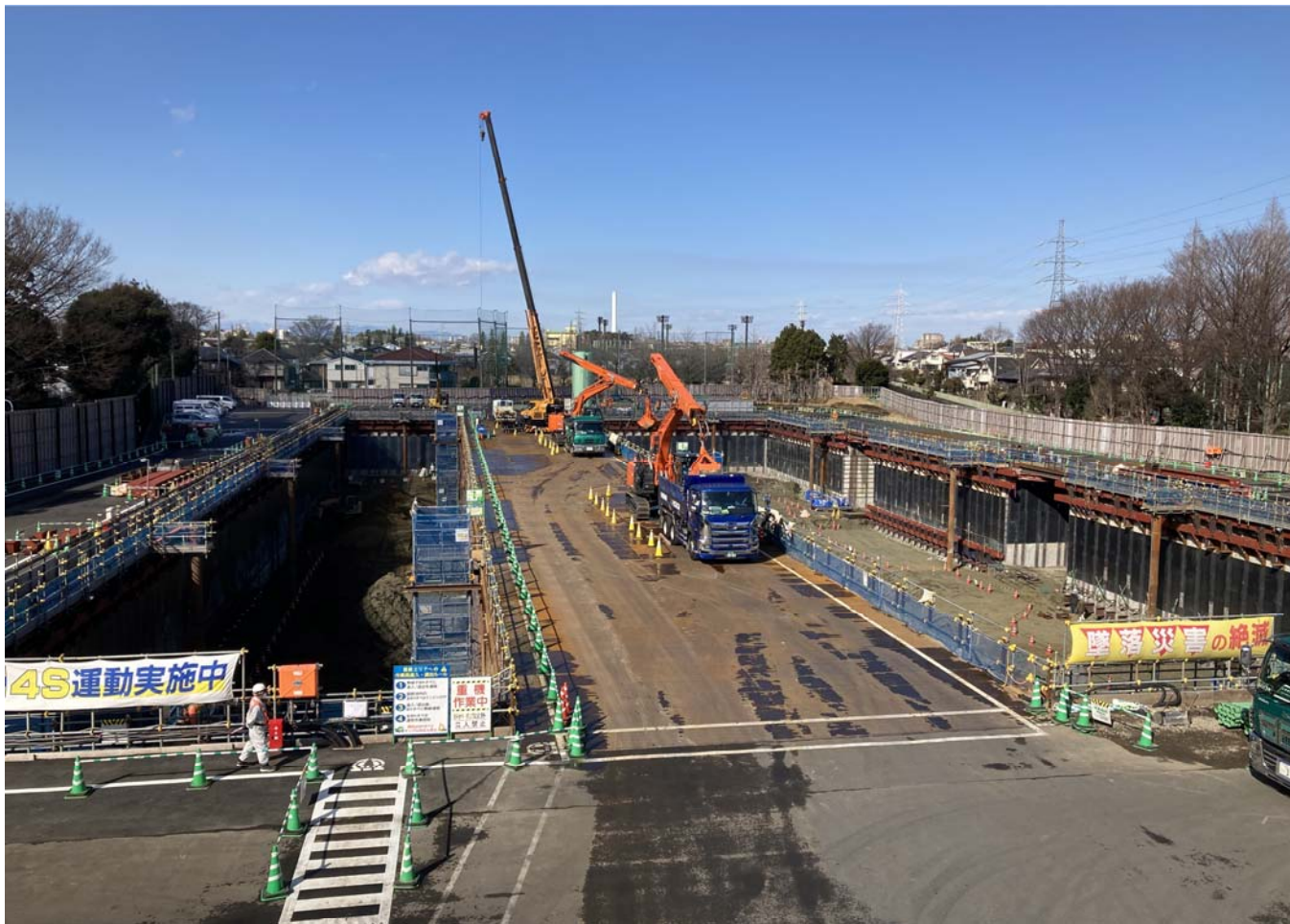
調節池ヤード 南側を望む
