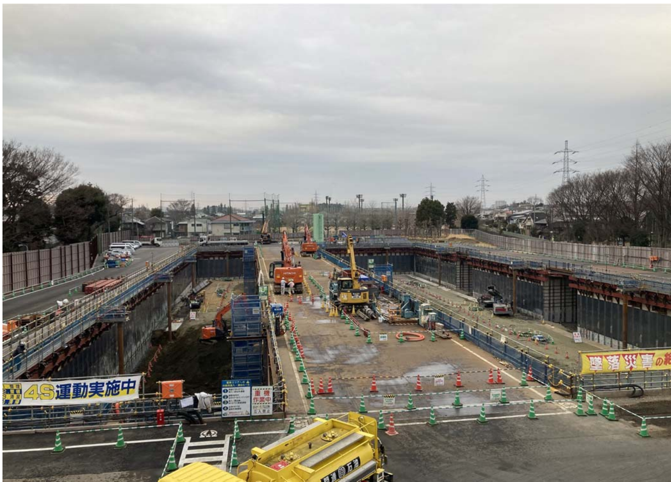
調節池ヤード 南側を望む
