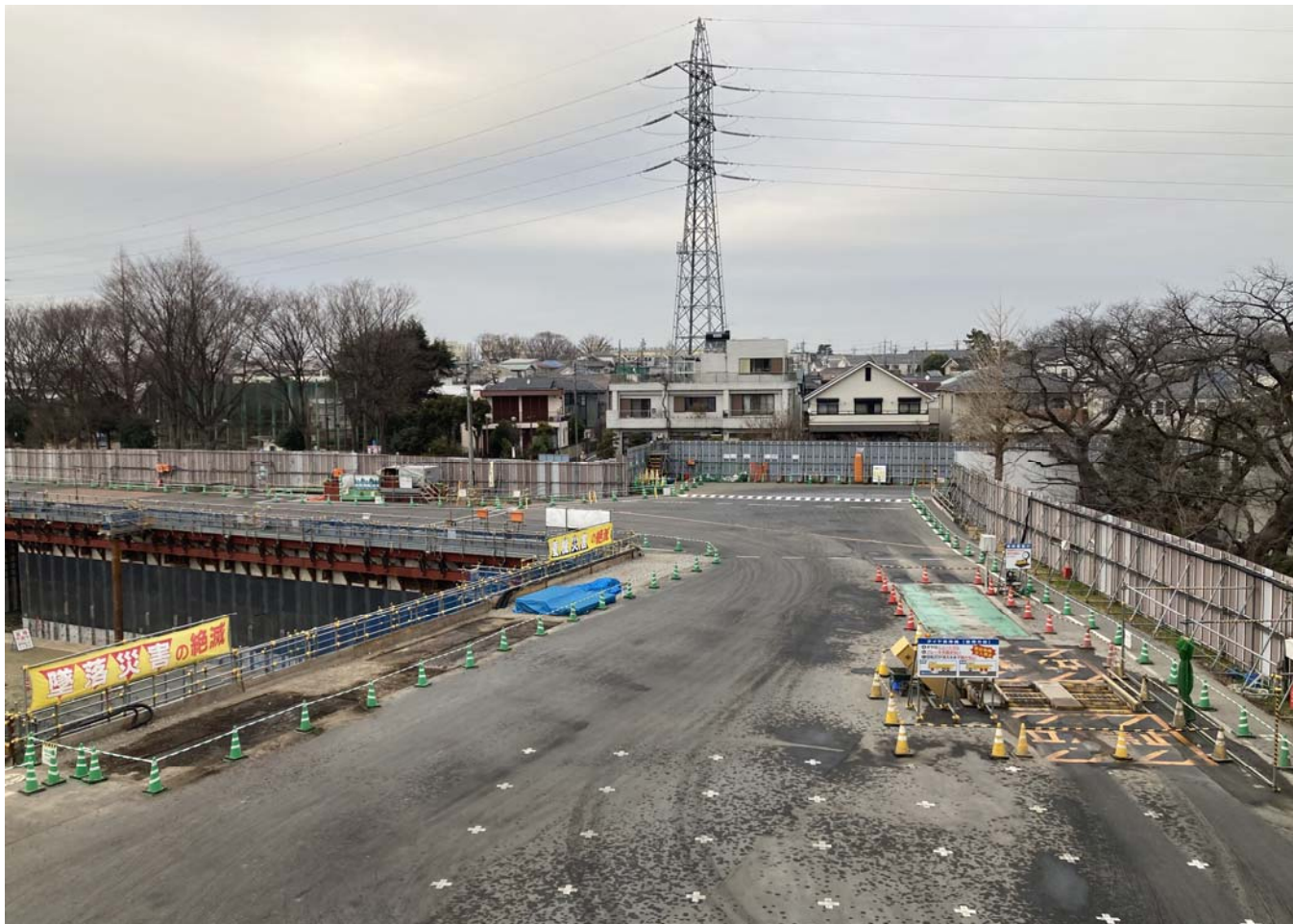
調節池ヤード 北側を望む
