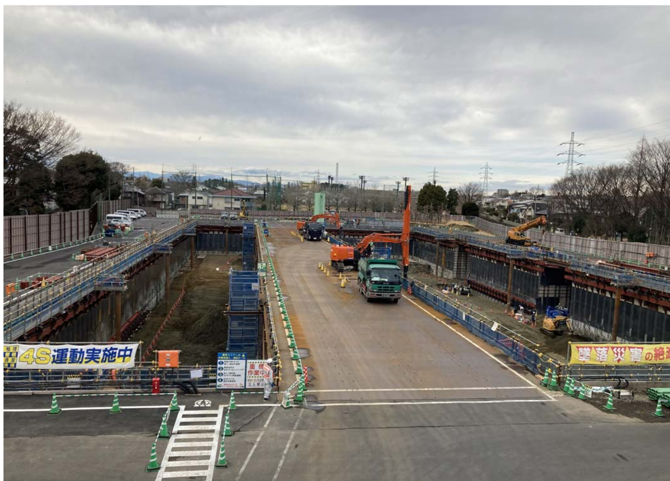
調節池ヤード 南側を望む
