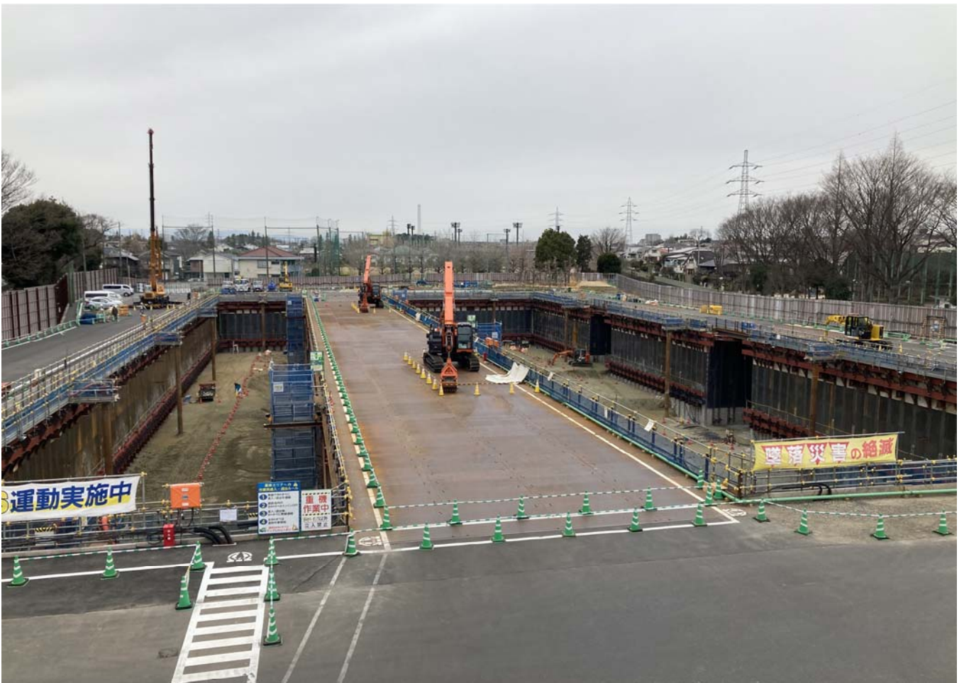
調節池ヤード 南側を望む
