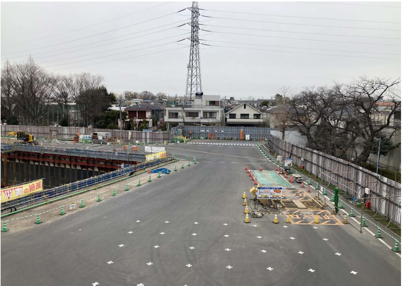
調節池ヤード 北側を望む
