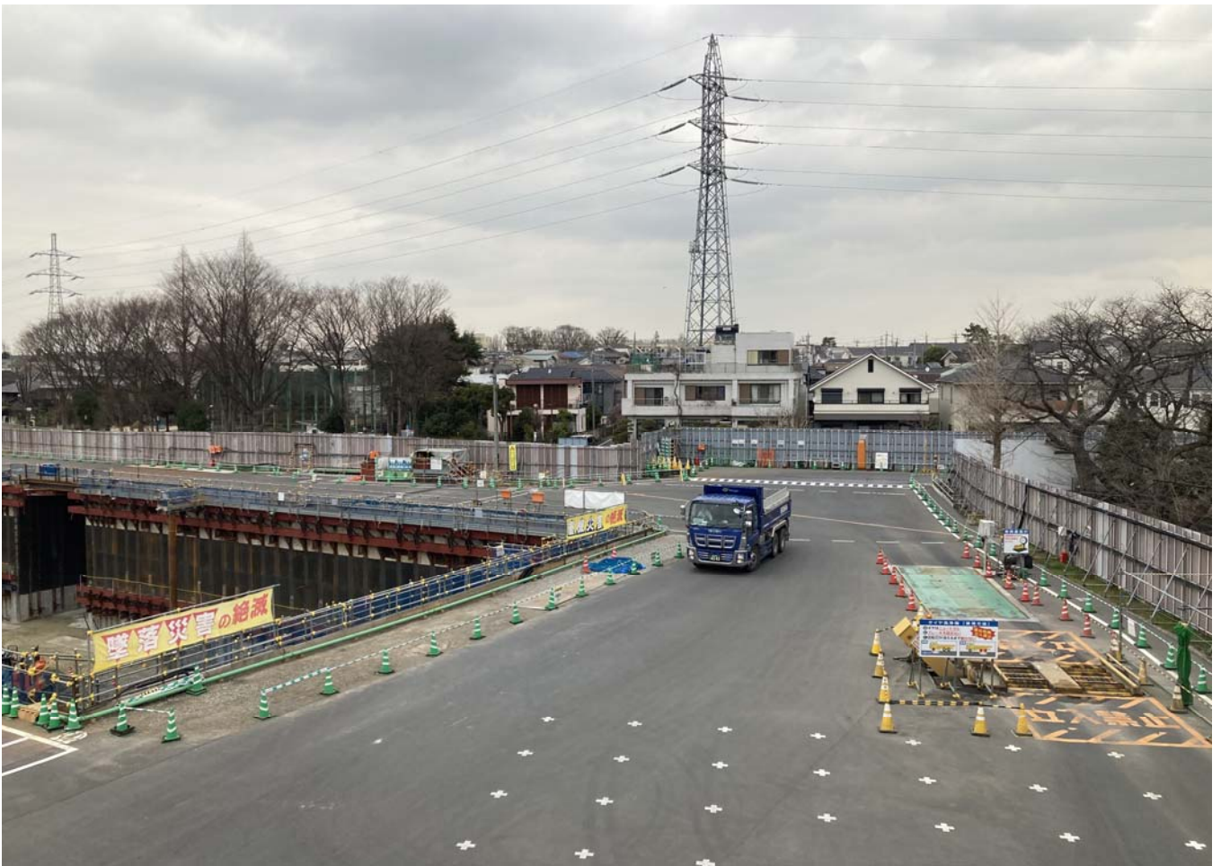
調節池ヤード 北側を望む
