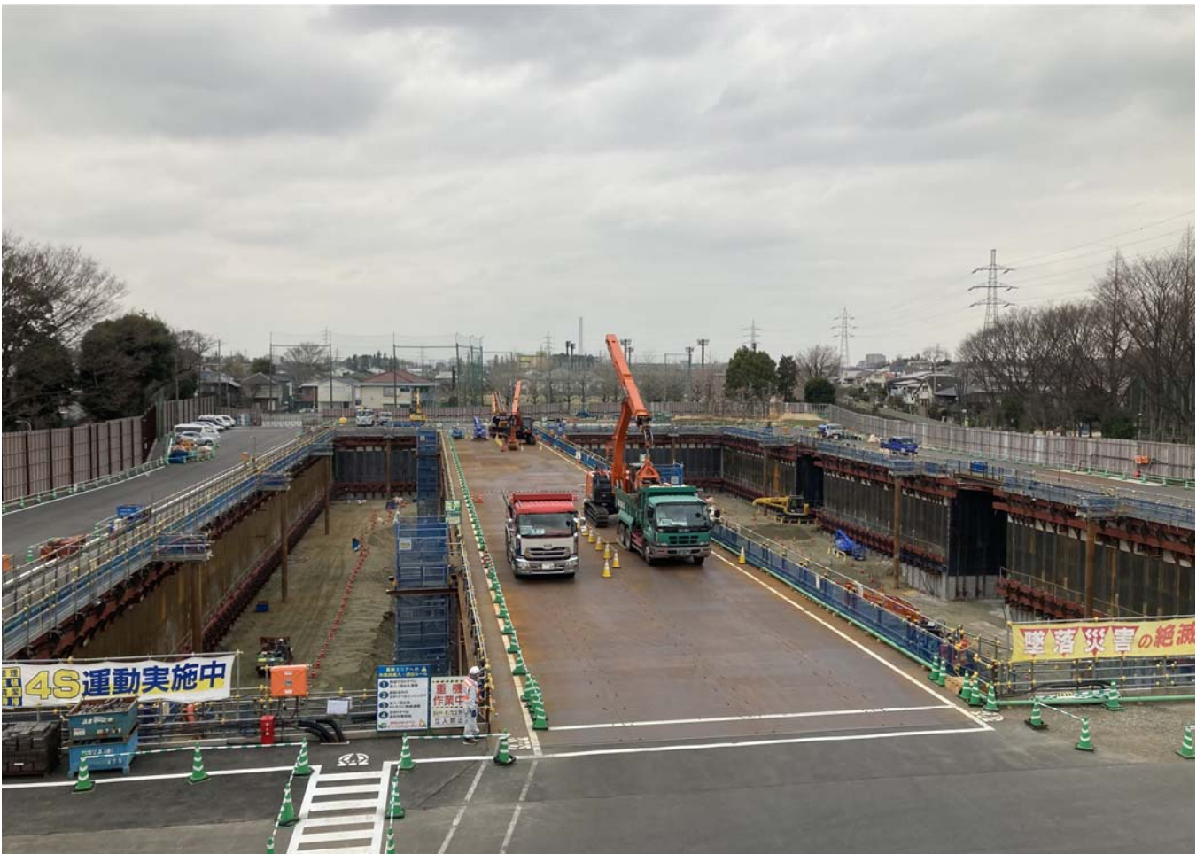
調節池ヤード 南側を望む
