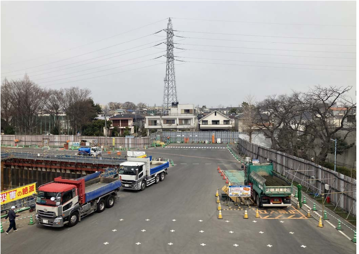
調節池ヤード 北側を望む
