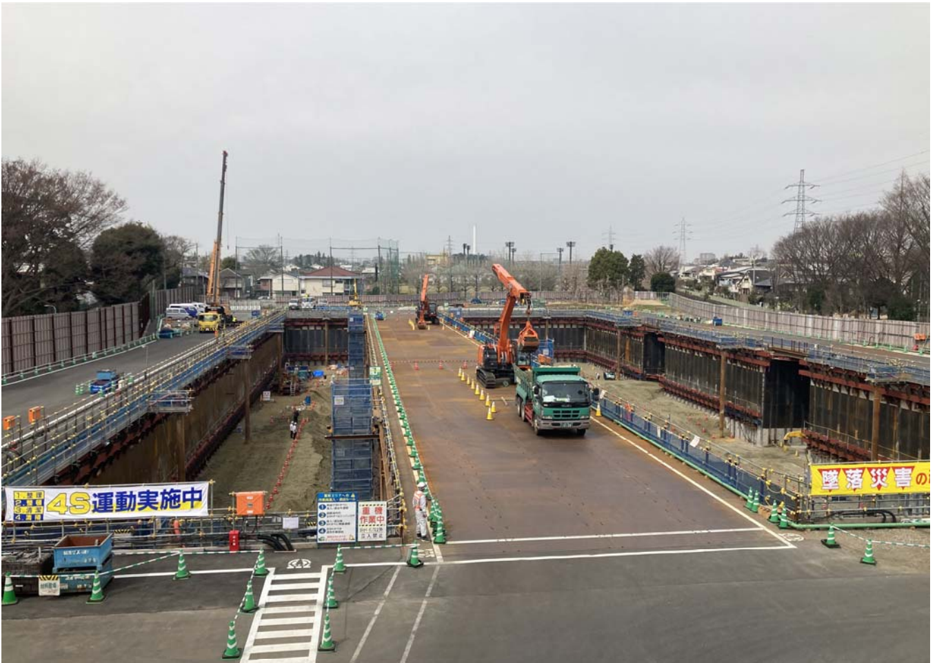
調節池ヤード 南側を望む
