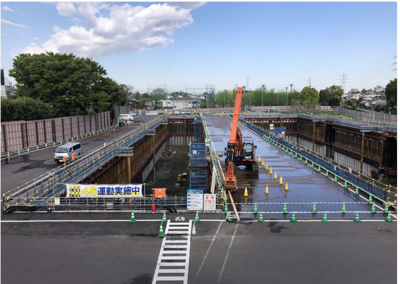
調節池ヤード 南側を望む
