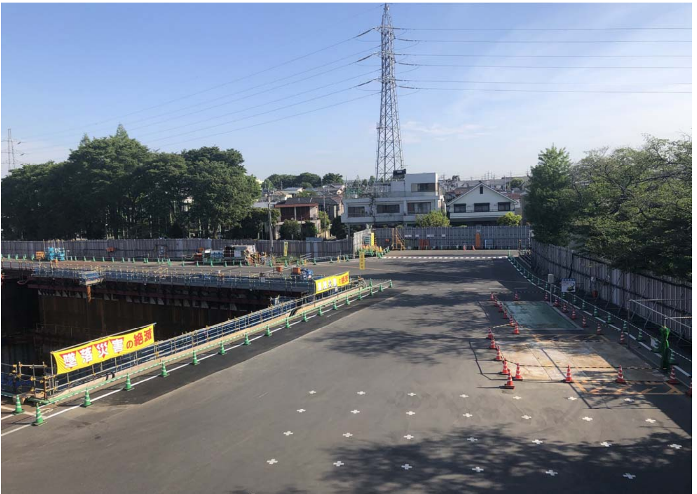
調節池ヤード 北側を望む
