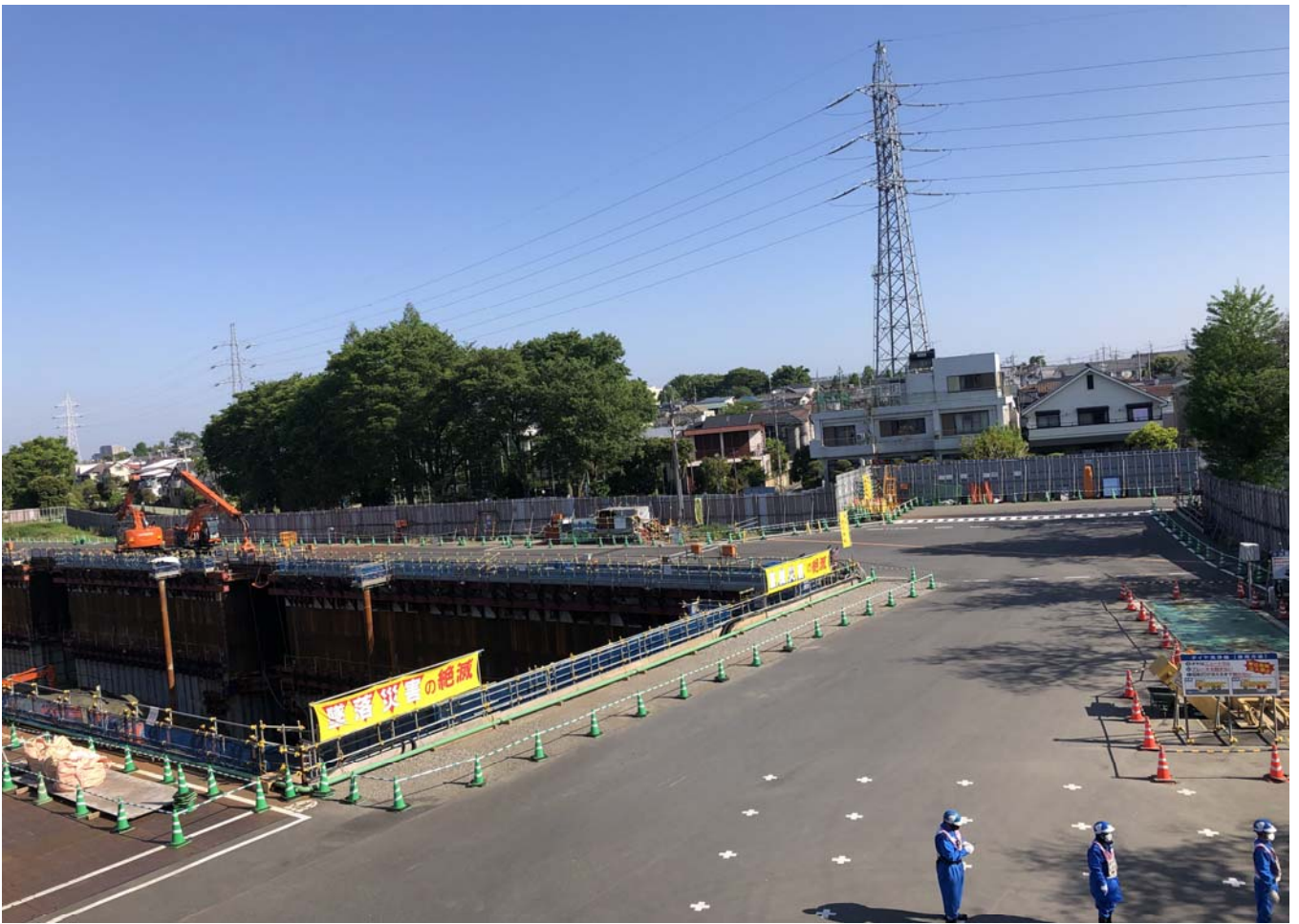
調節池ヤード 北側を望む
