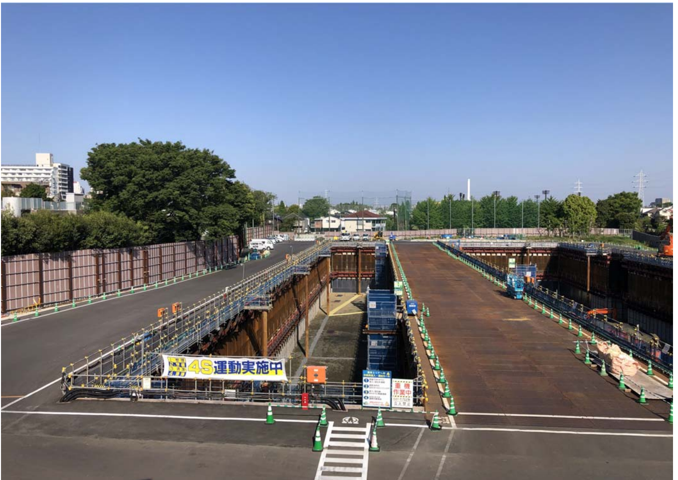
調節池ヤード 南側を望む
