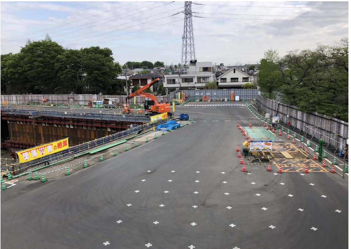
調節池ヤード 北側を望む
