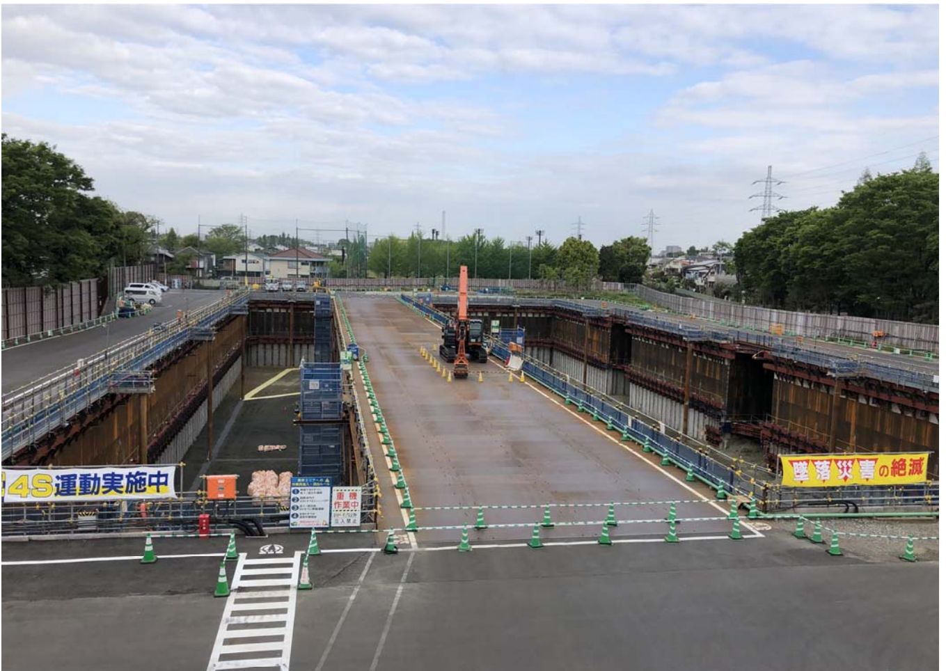
調節池ヤード 南側を望む
