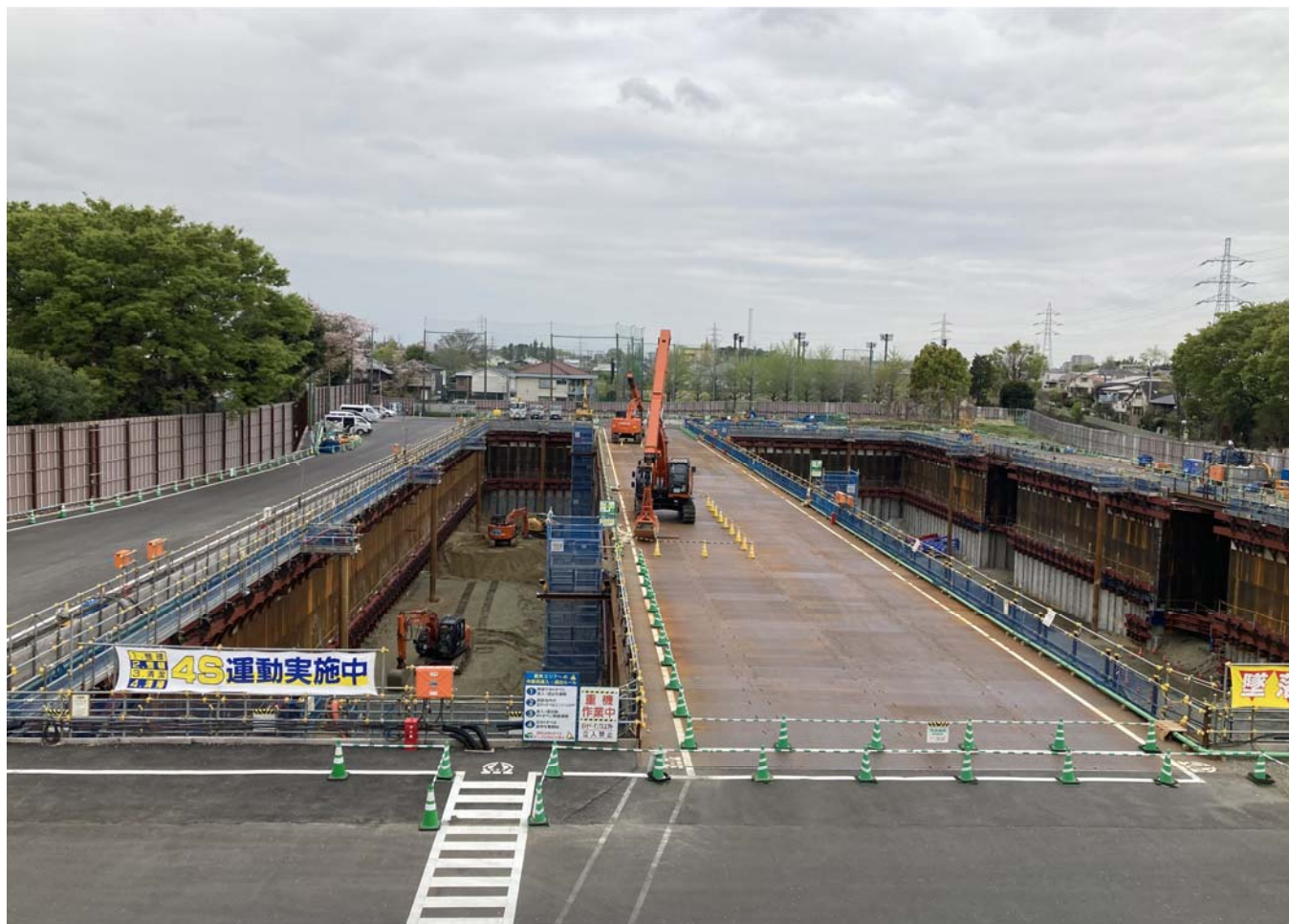
調節池ヤード 南側を望む
