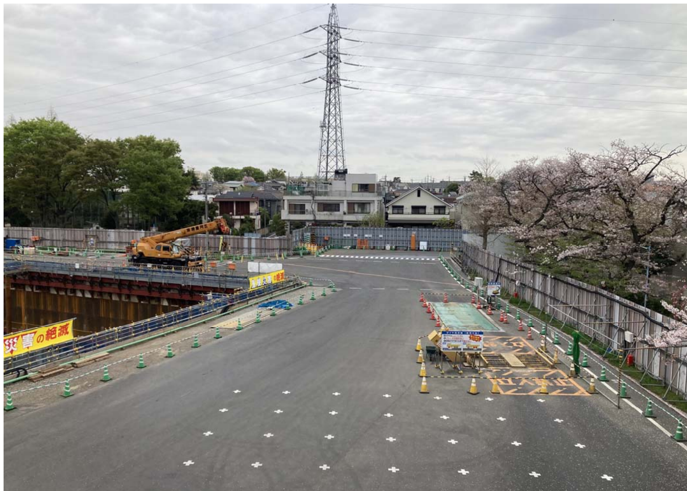
調節池ヤード 北側を望む
