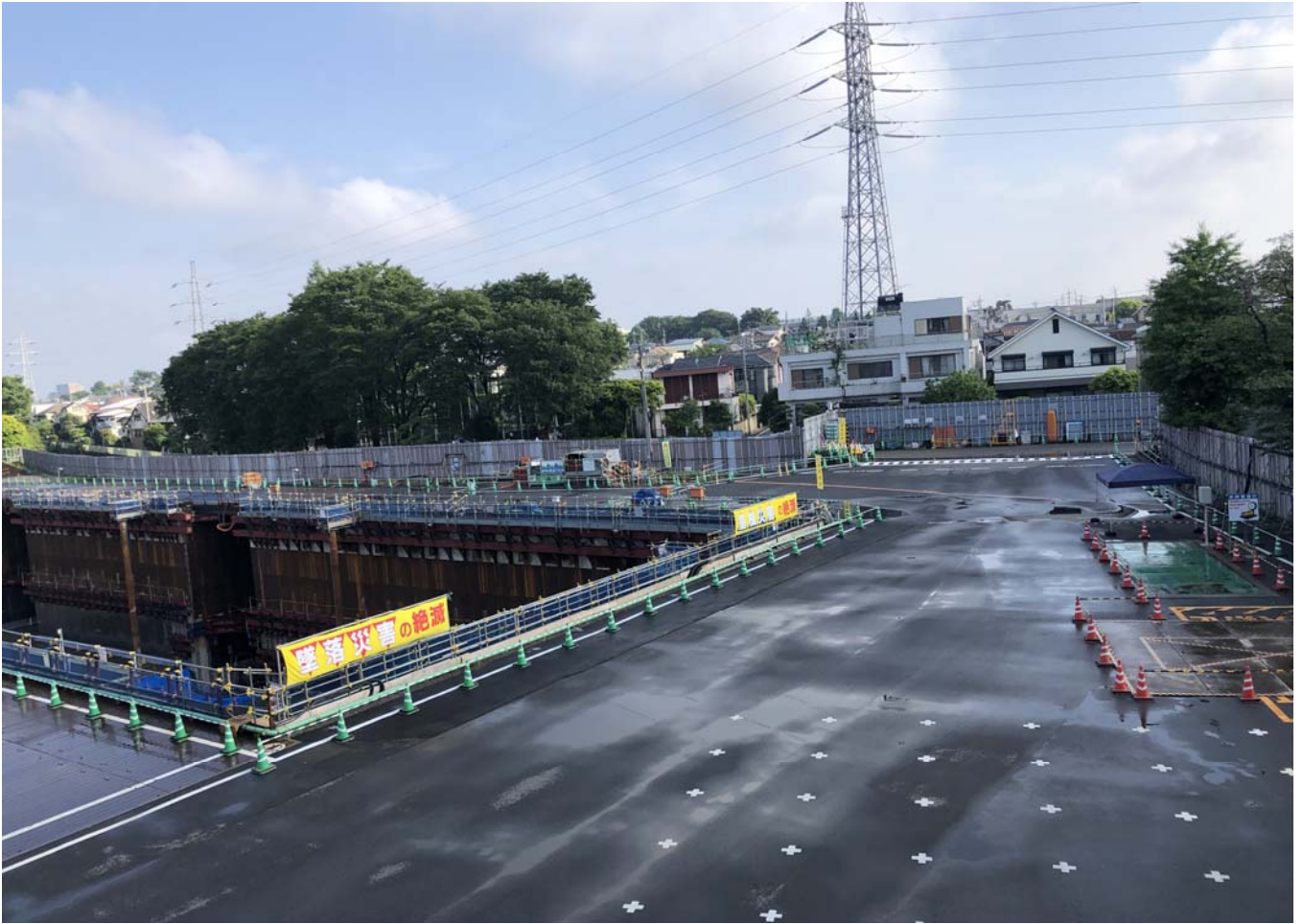
調節池ヤード 北側を望む
