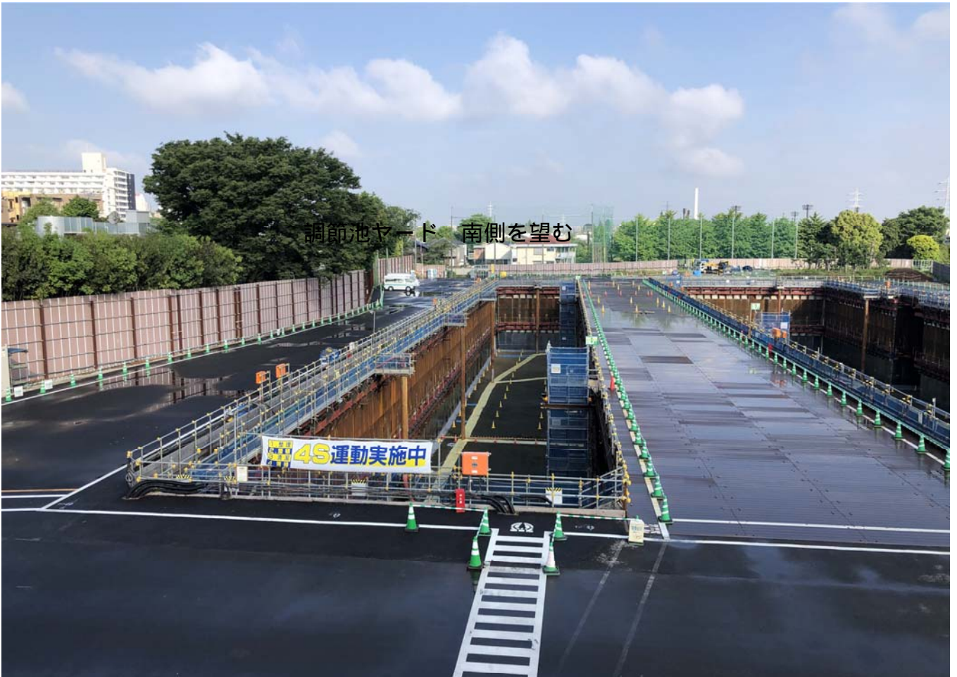
調節池ヤード 南側を望む
