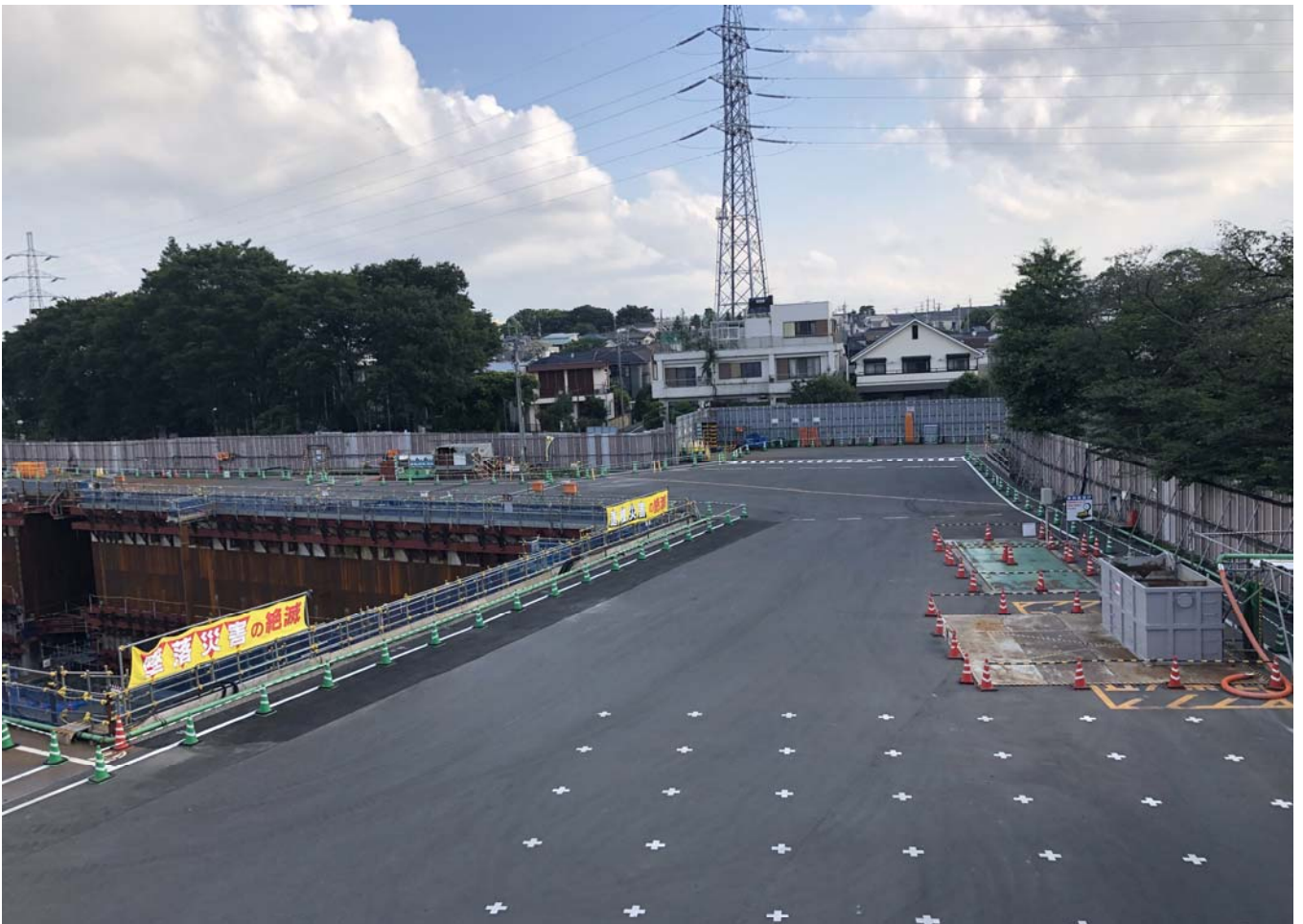
調節池ヤード 北側を望む
