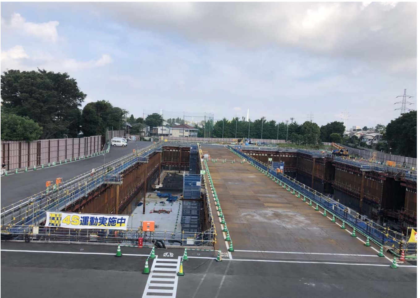
調節池ヤード 南側を望む
