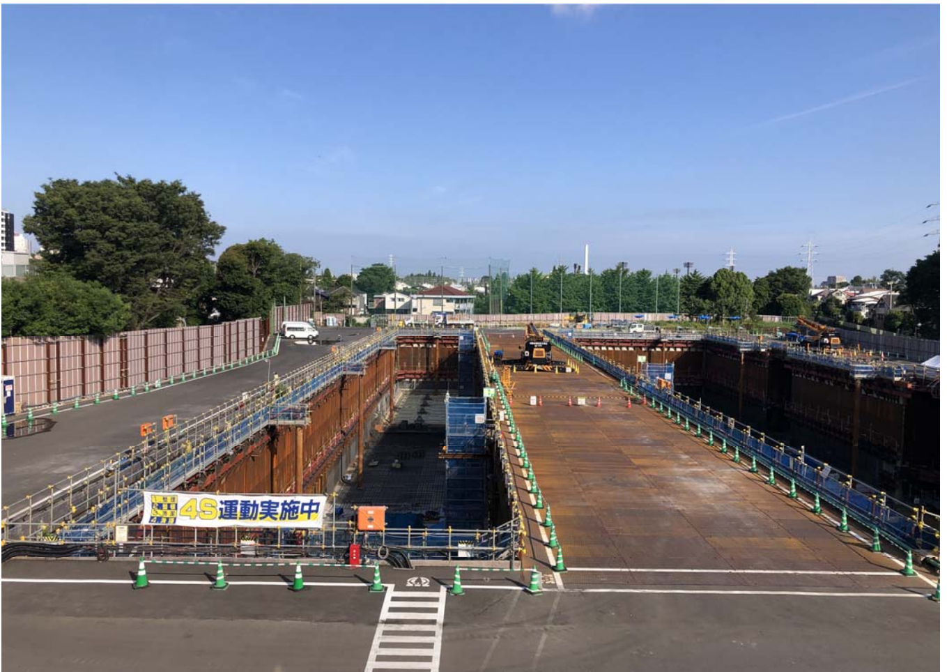
調節池ヤード 南側を望む
