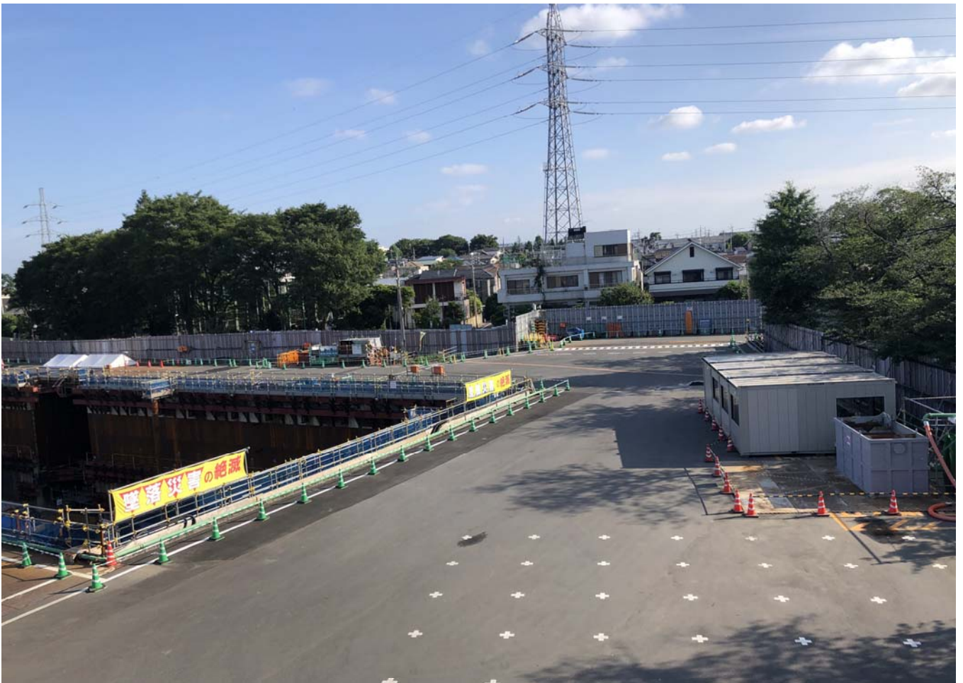
調節池ヤード 北側を望む
