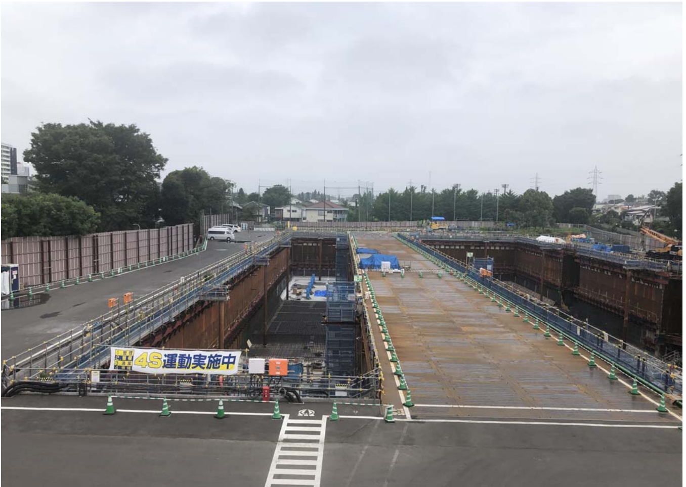
調節池ヤード 南側を望む
