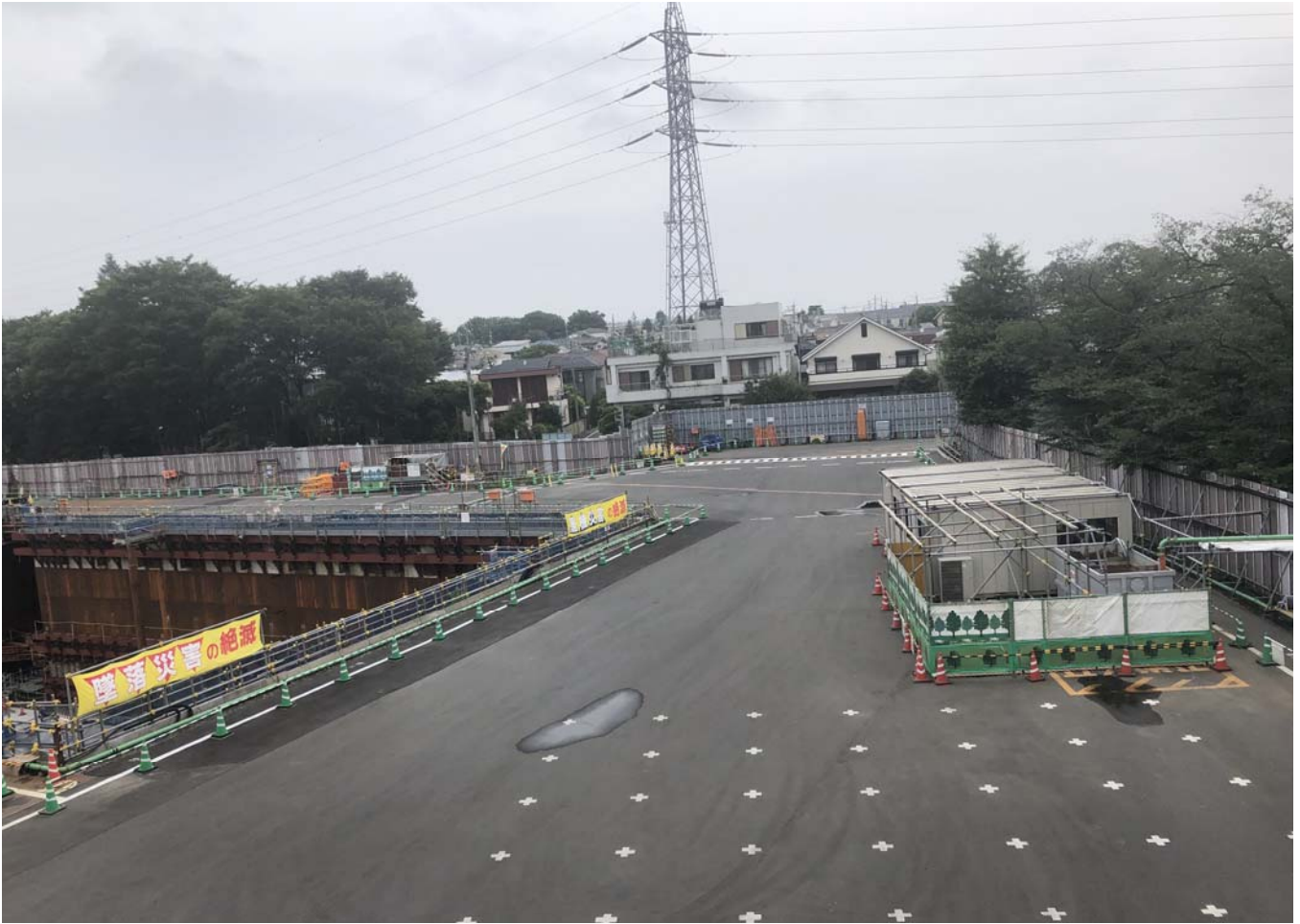
調節池ヤード 北側を望む
