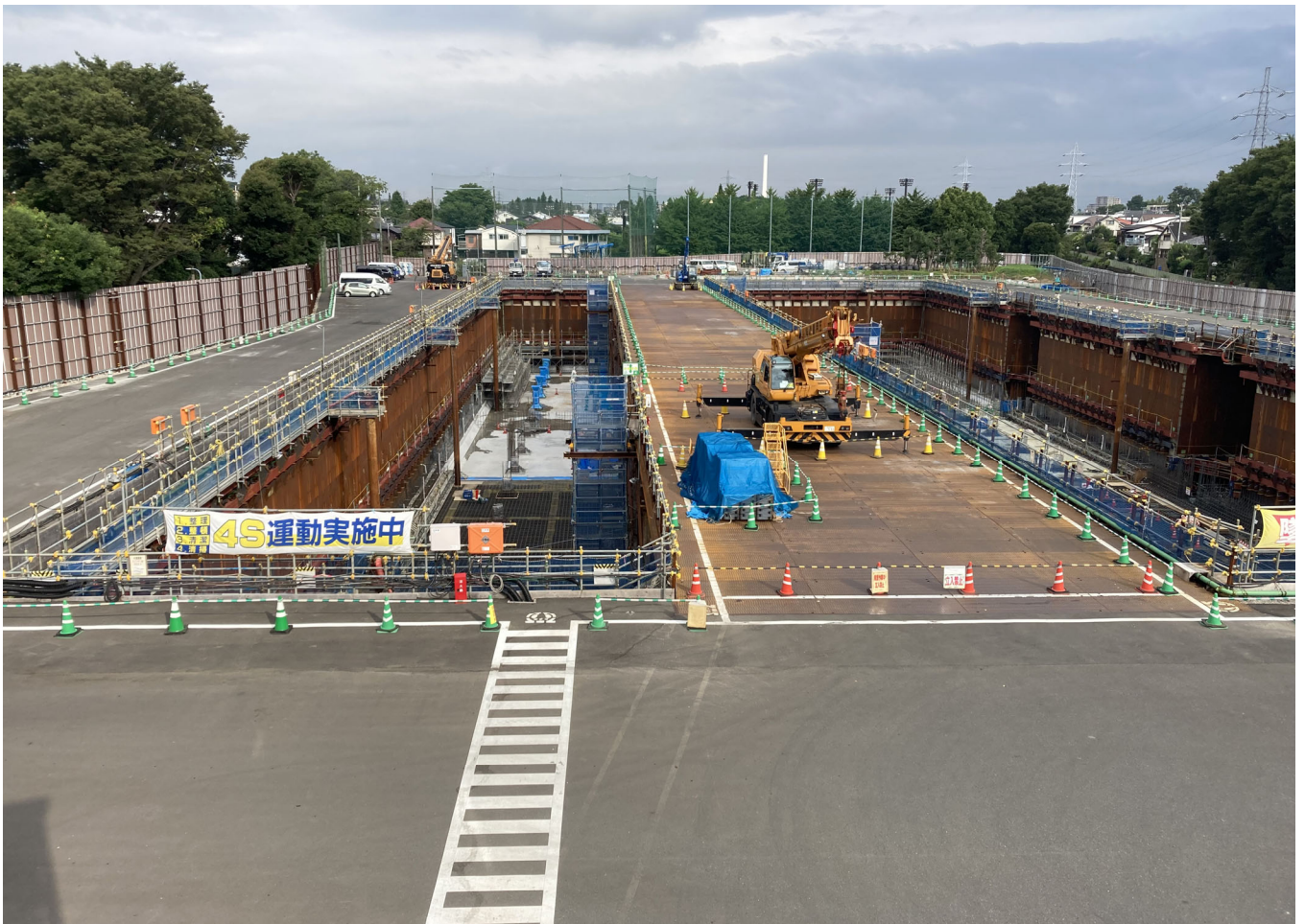
調節池ヤード 北側を望む
