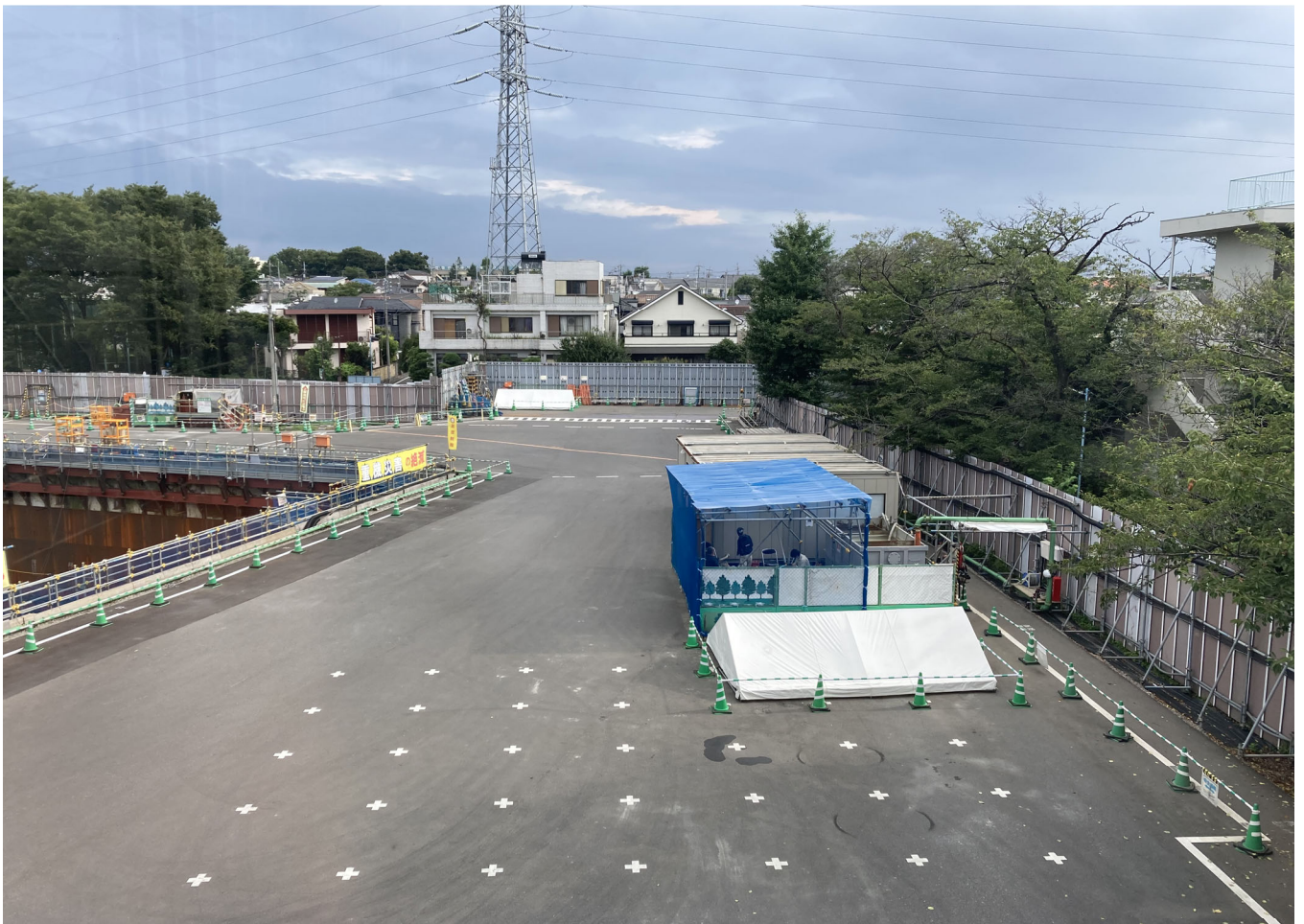
調節池ヤード 南側を望む
