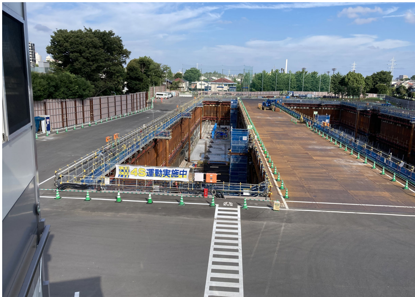
調節池ヤード 北側を望む
