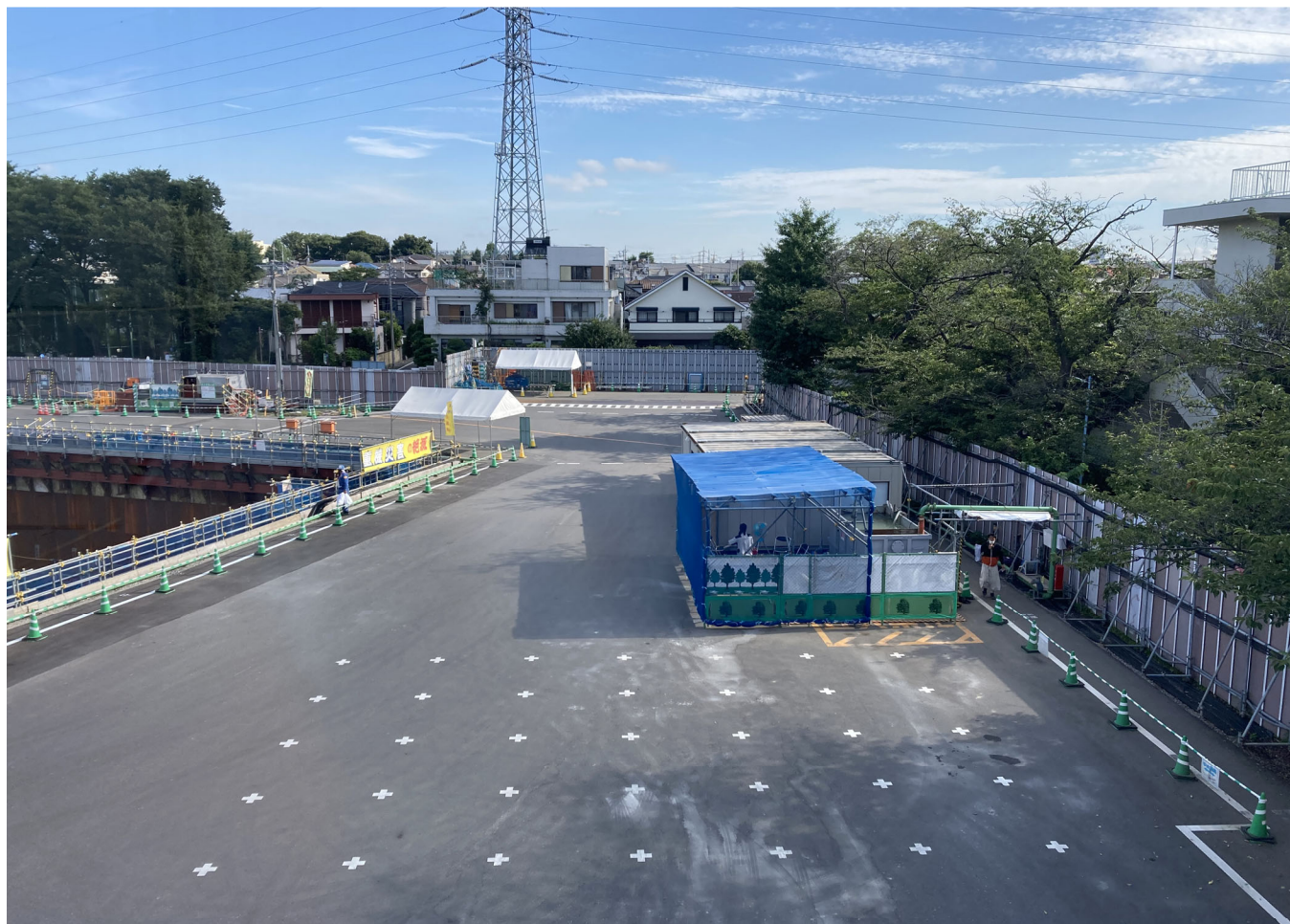
調節池ヤード 南側を望む
