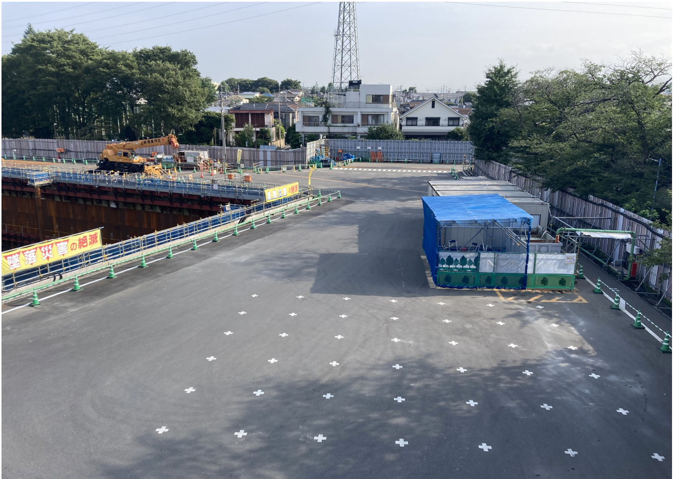
調節池ヤード 南側を望む
