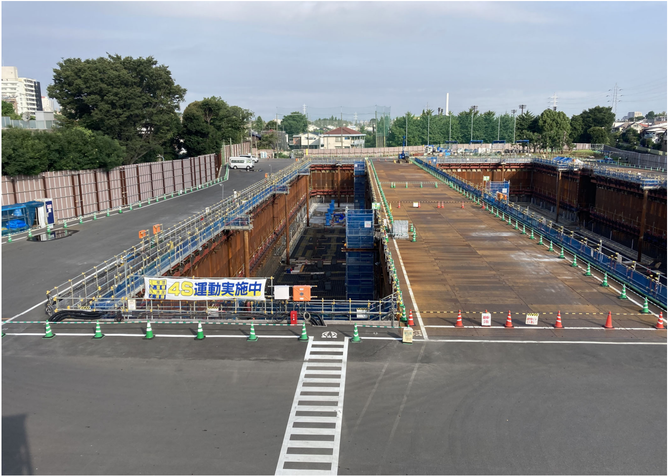
調節池ヤード 北側を望む
