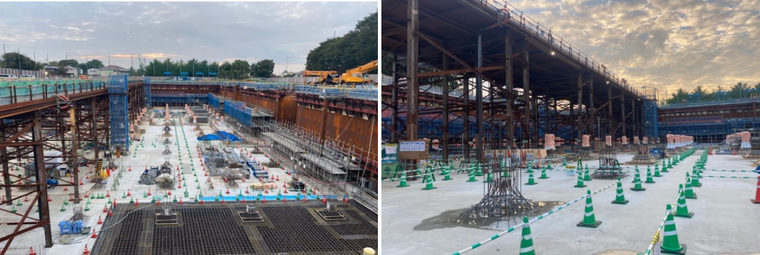
調節池ヤード 全景
