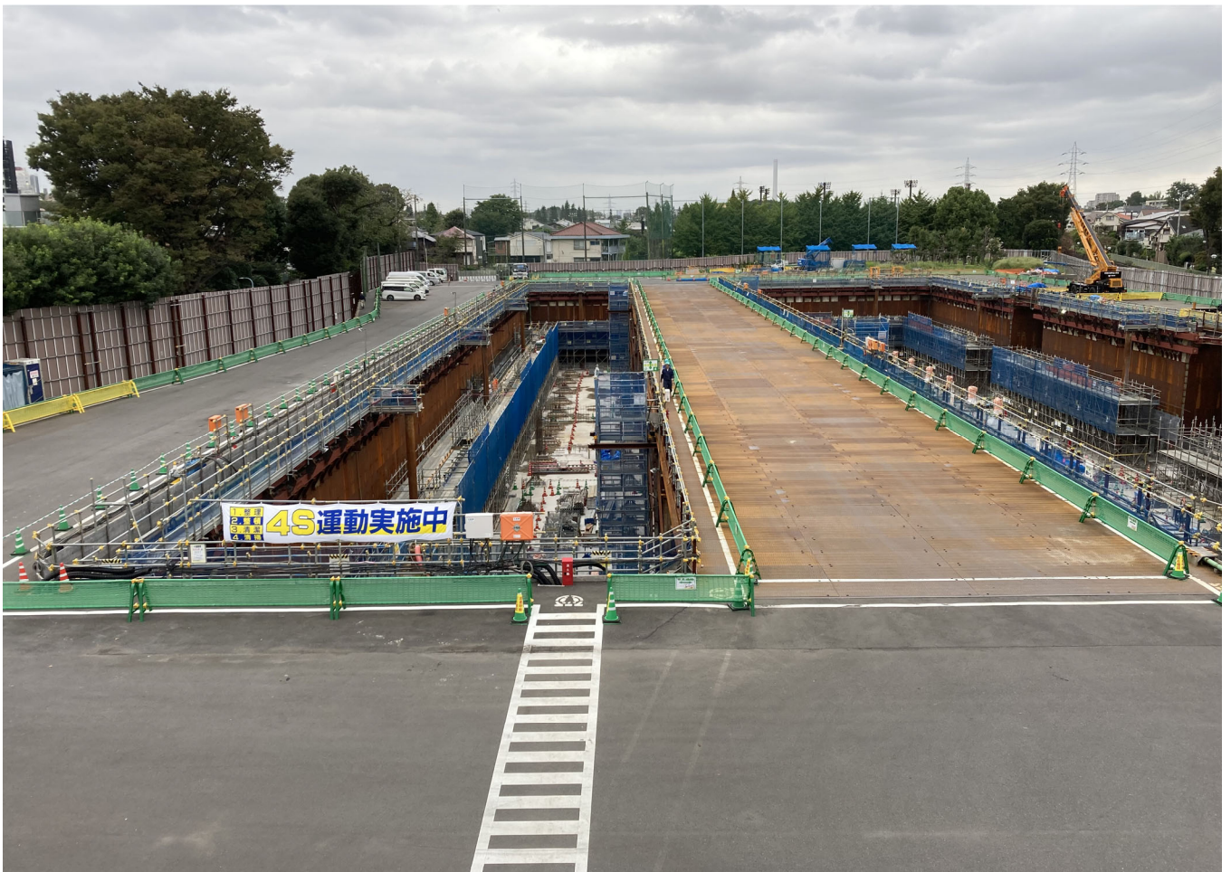
調節池ヤード 南側を望む
