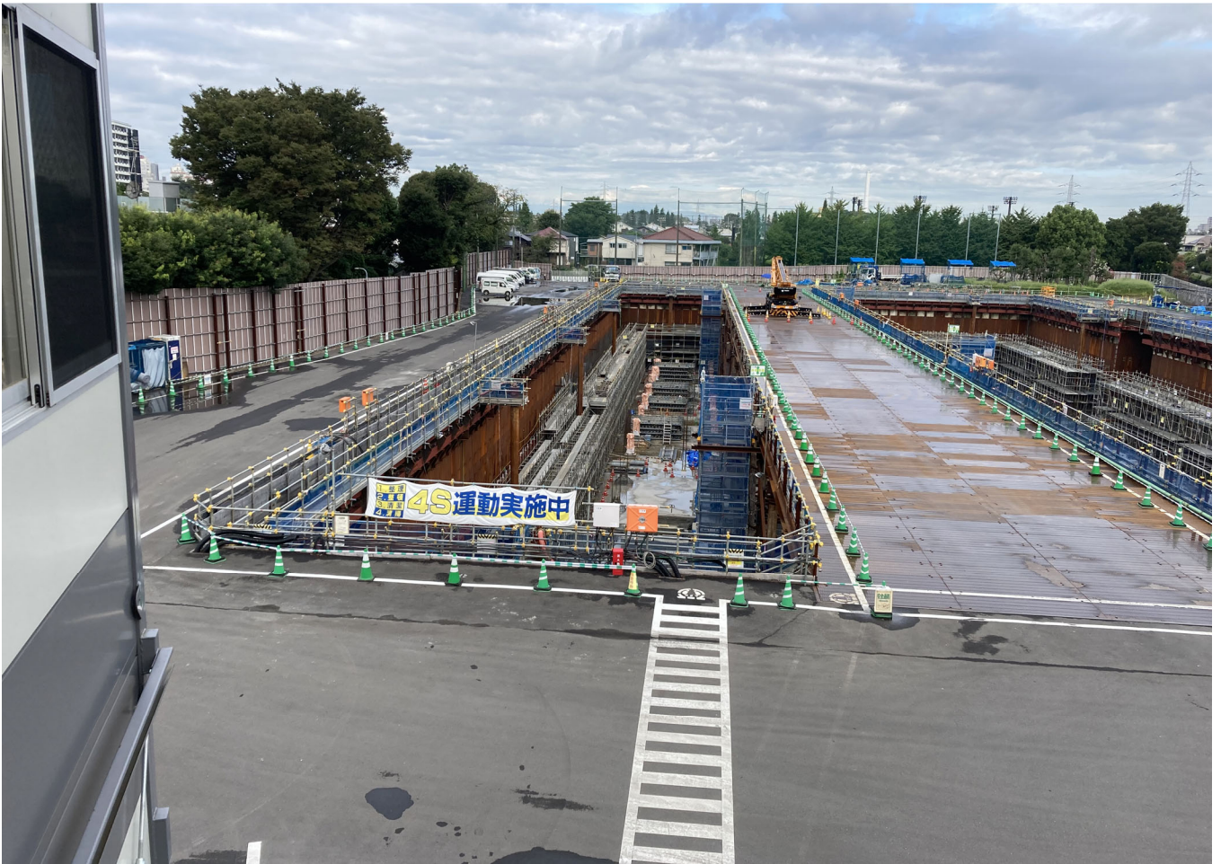
調節池ヤード 南側を望む
