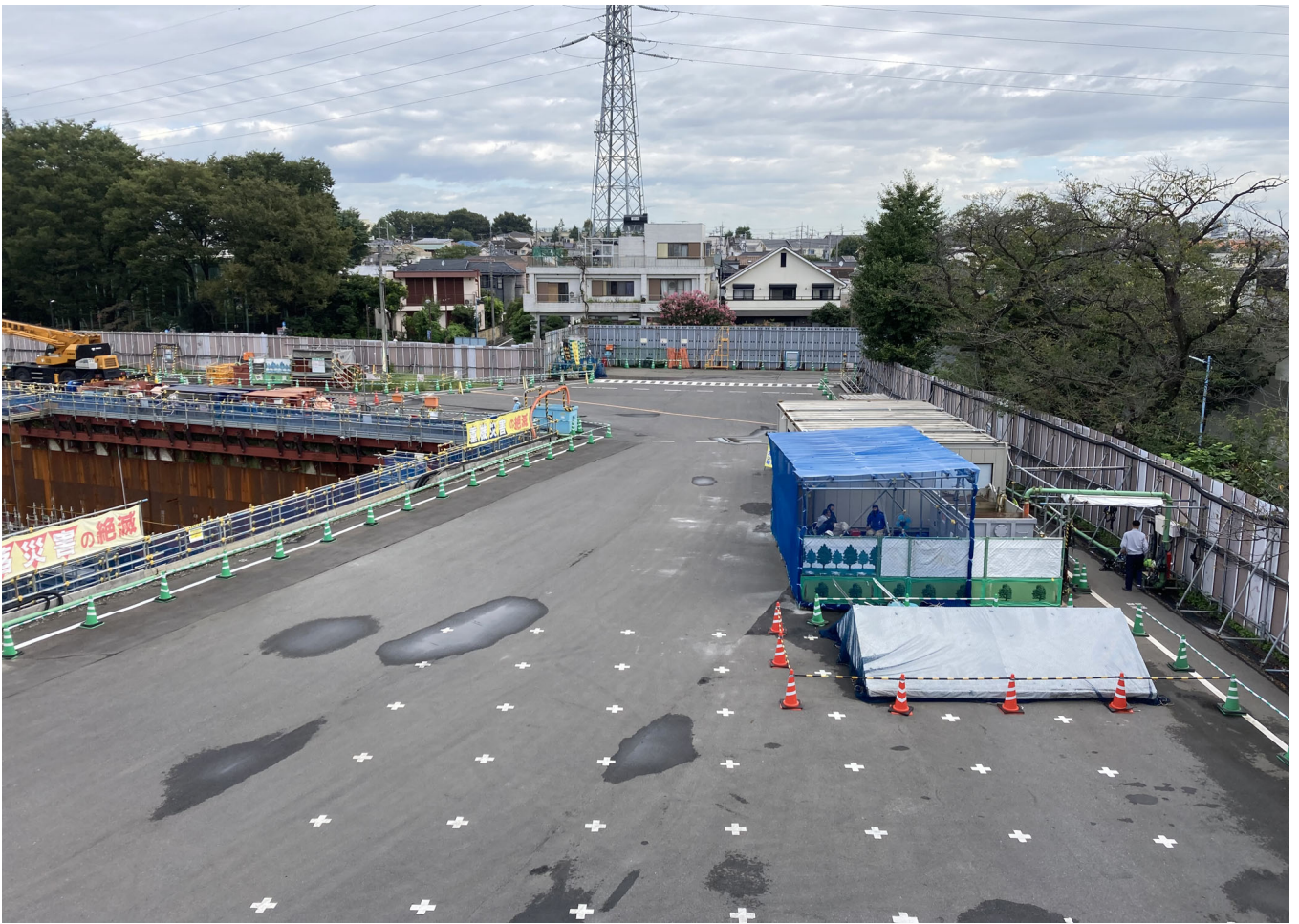
調節池ヤード 北側を望む
