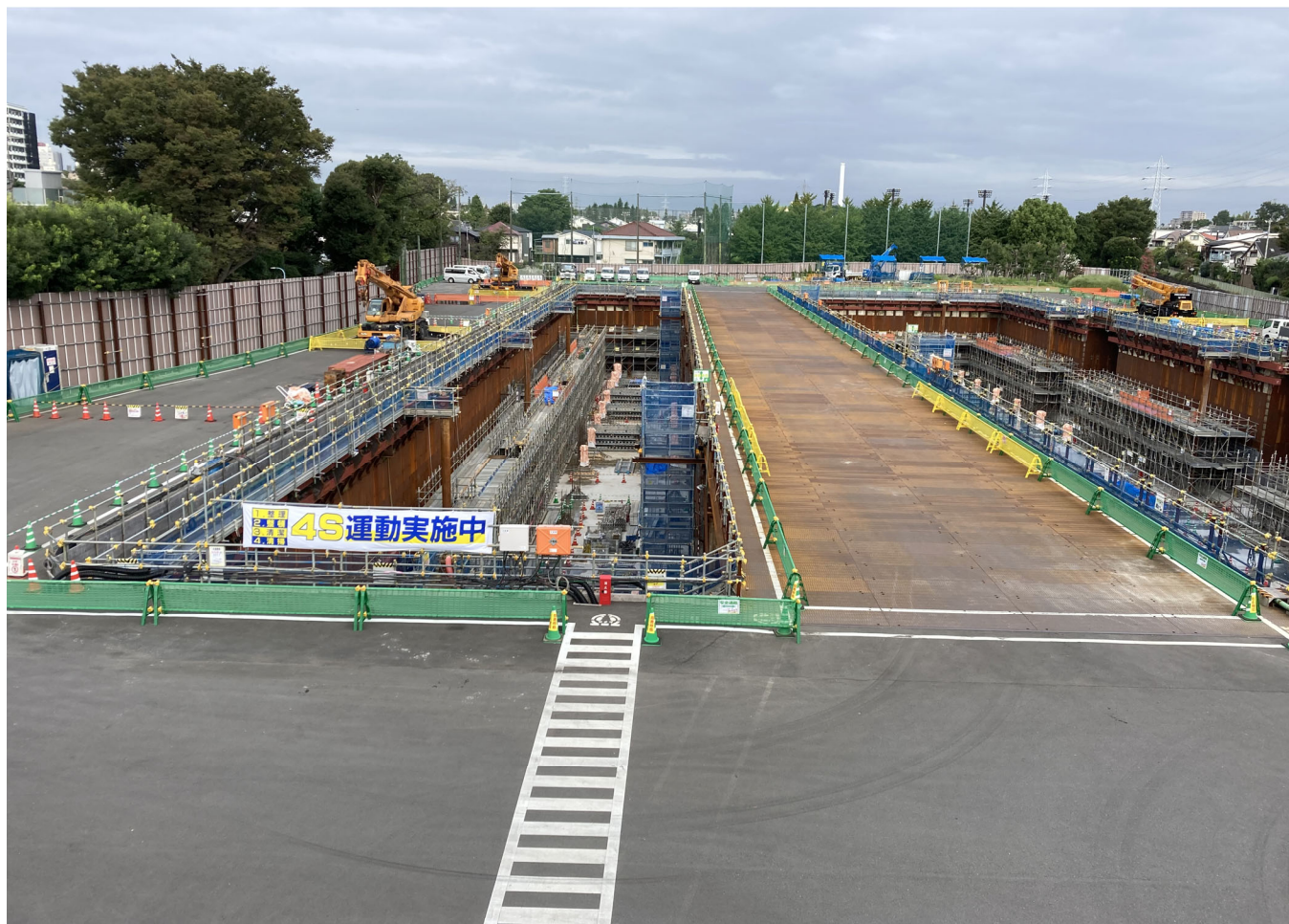
調節池ヤード 南側を望む
