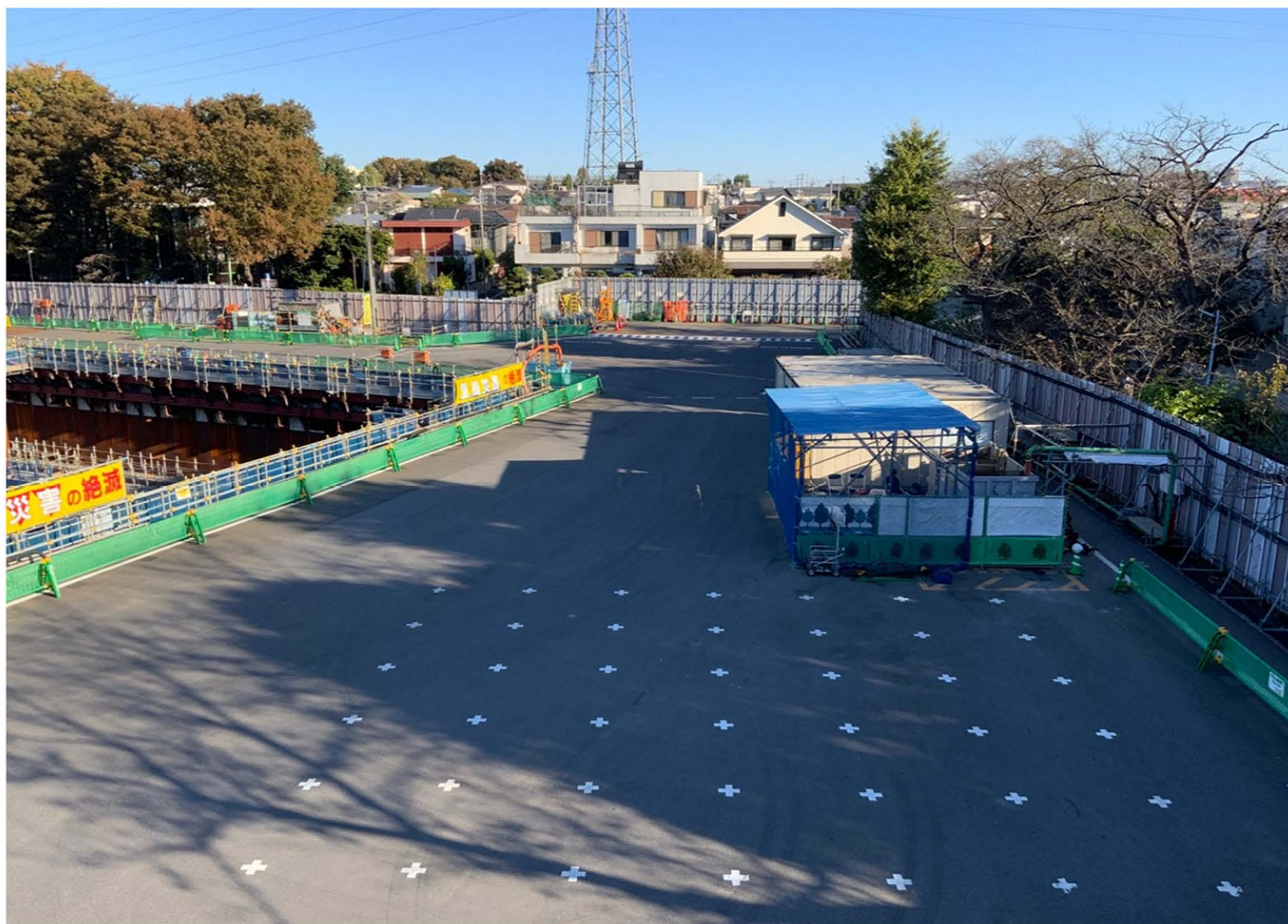
調節池ヤード 北側を望む
