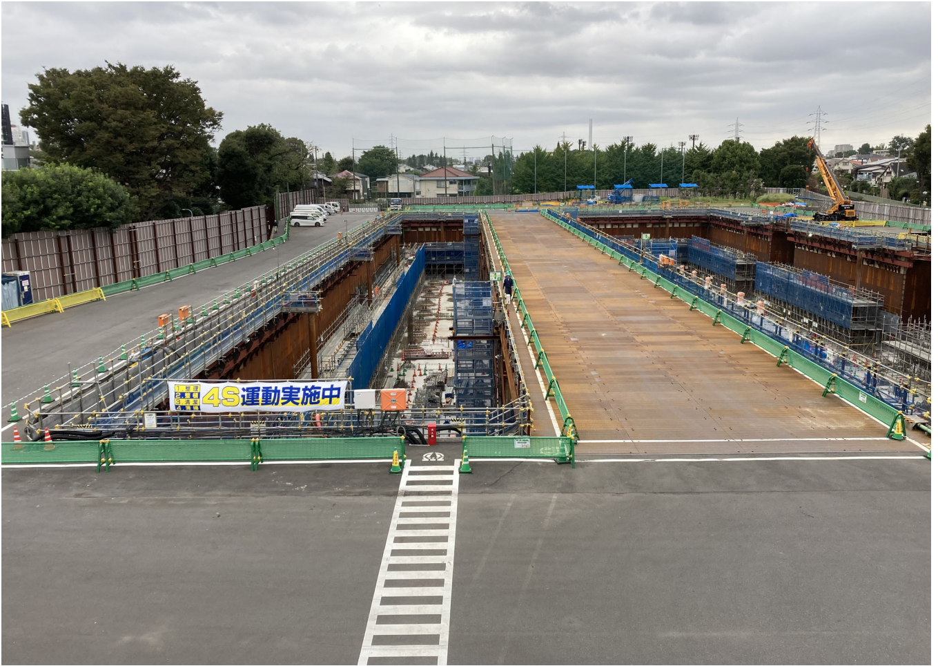
調節池ヤード 北側を望む
