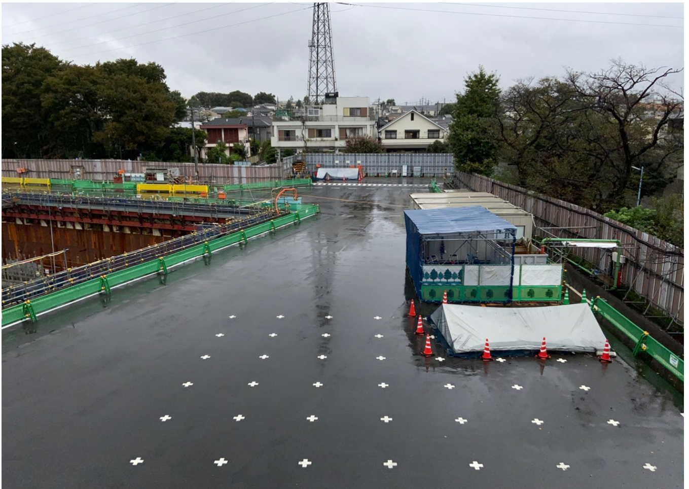
調節池ヤード 南側を望む
