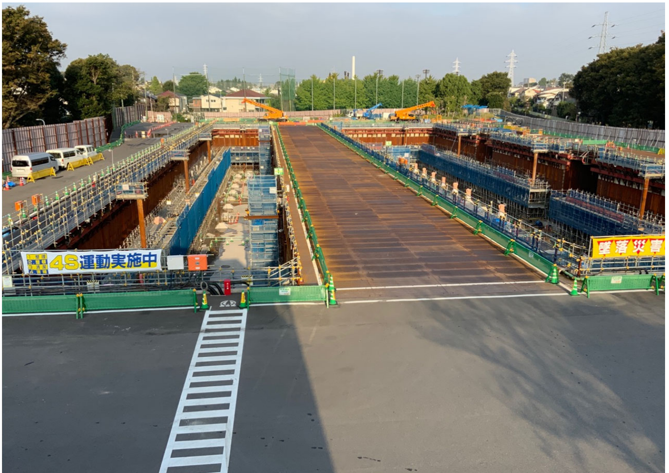
調節池ヤード 南側を望む
