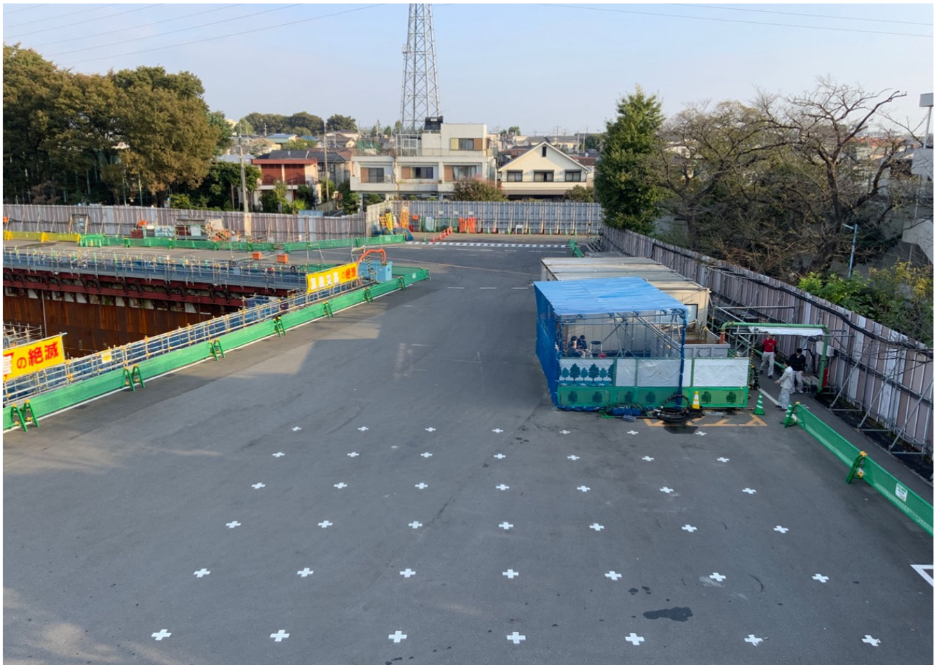
調節池ヤード 北側を望む
