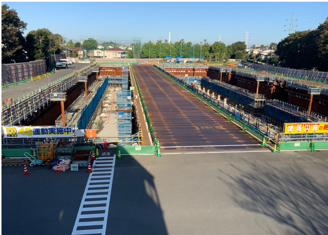
調節池ヤード 南側を望む
