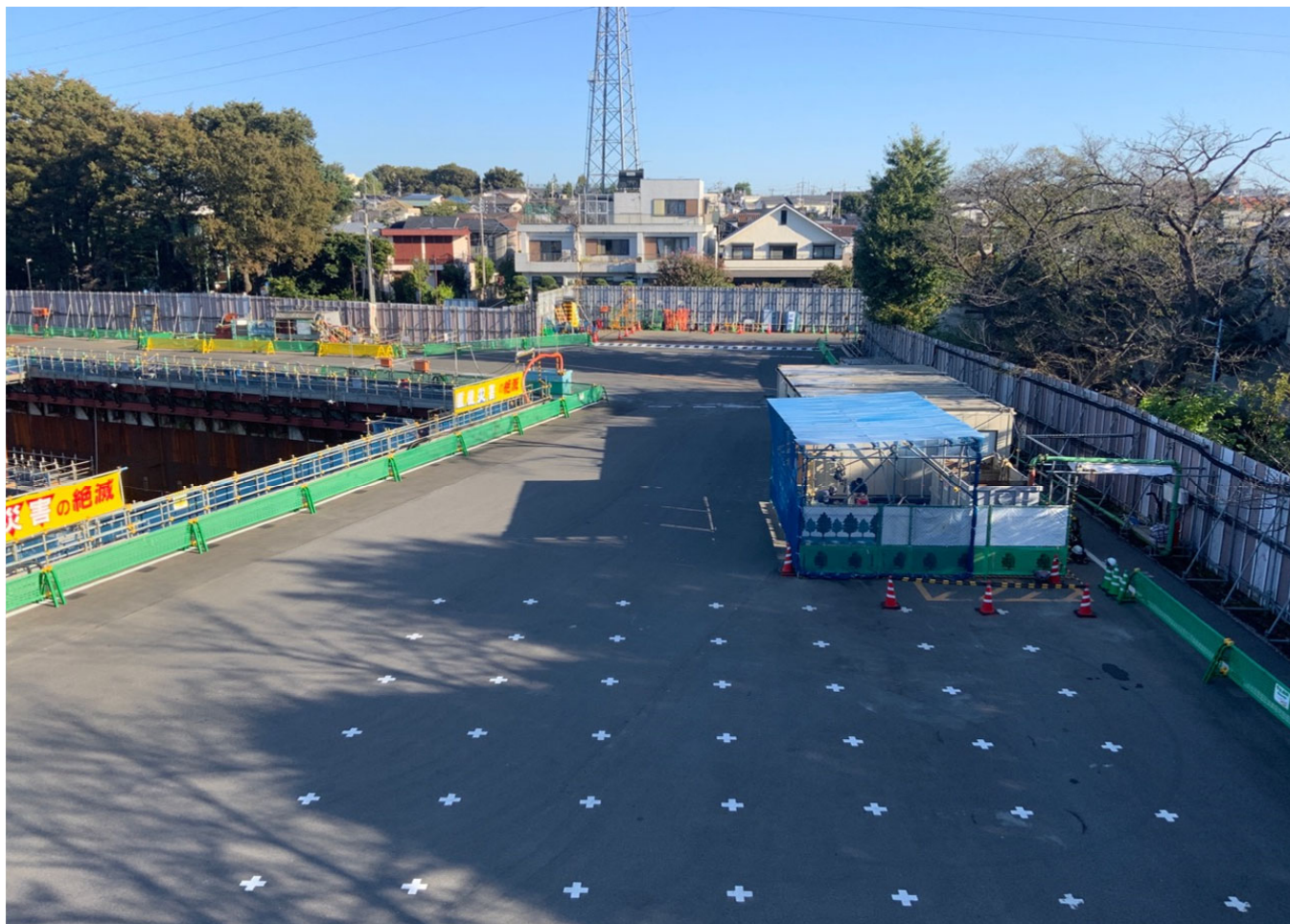
調節池ヤード 北側を望む
