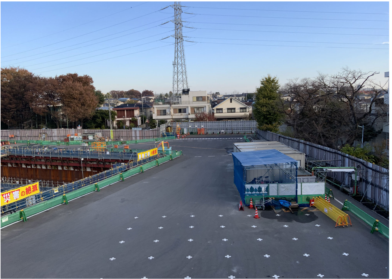
調節池ヤード 北側を望む
